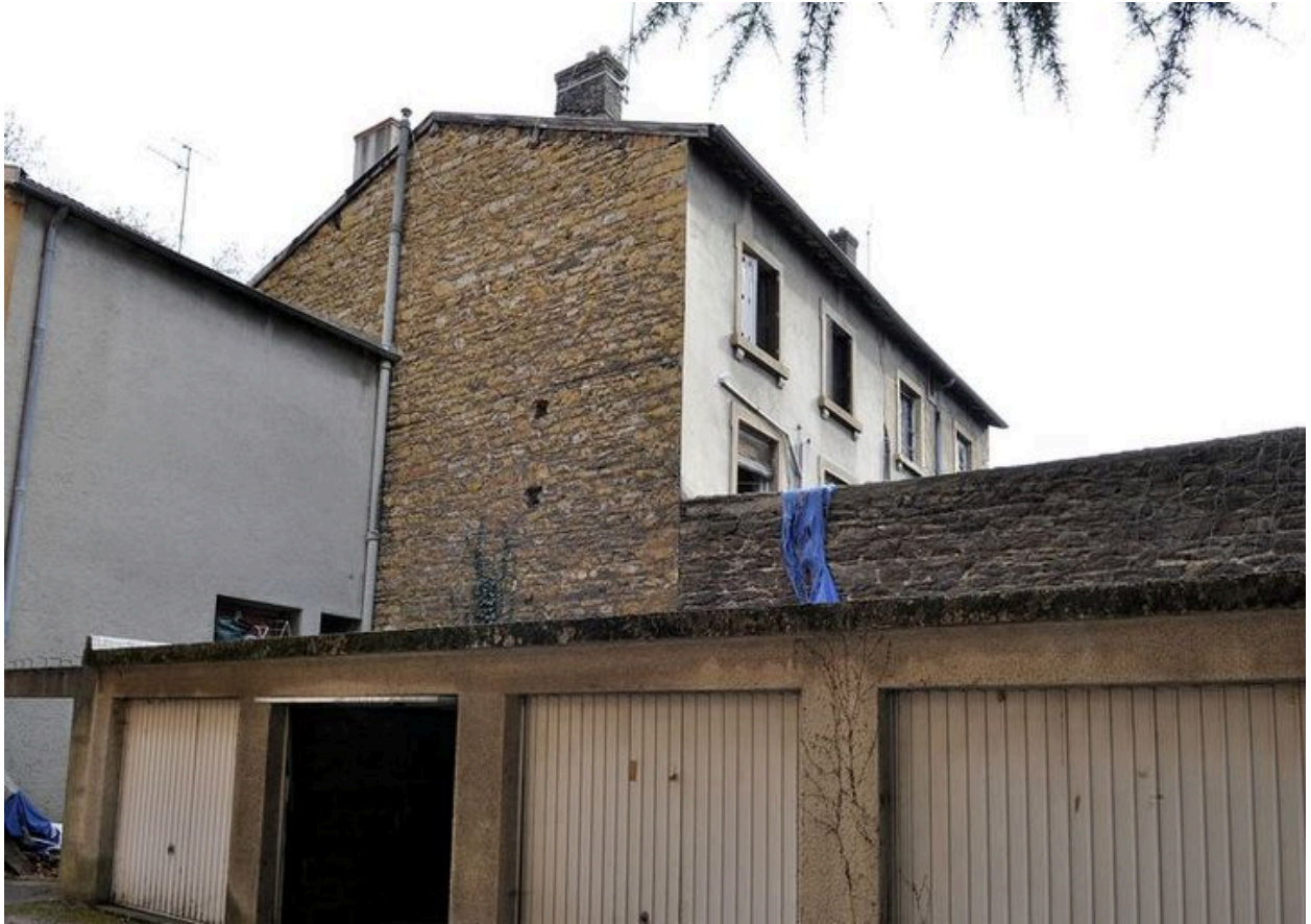
Façade latérale et façade postérieure
