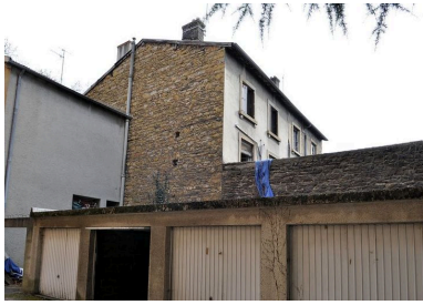
Façade latérale et façade postérieure Phot. Julien Defillon IVR82_20106900983NUCA
