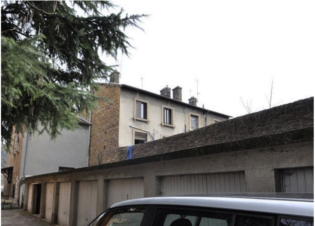
Façade postérieure et façade latérale.
