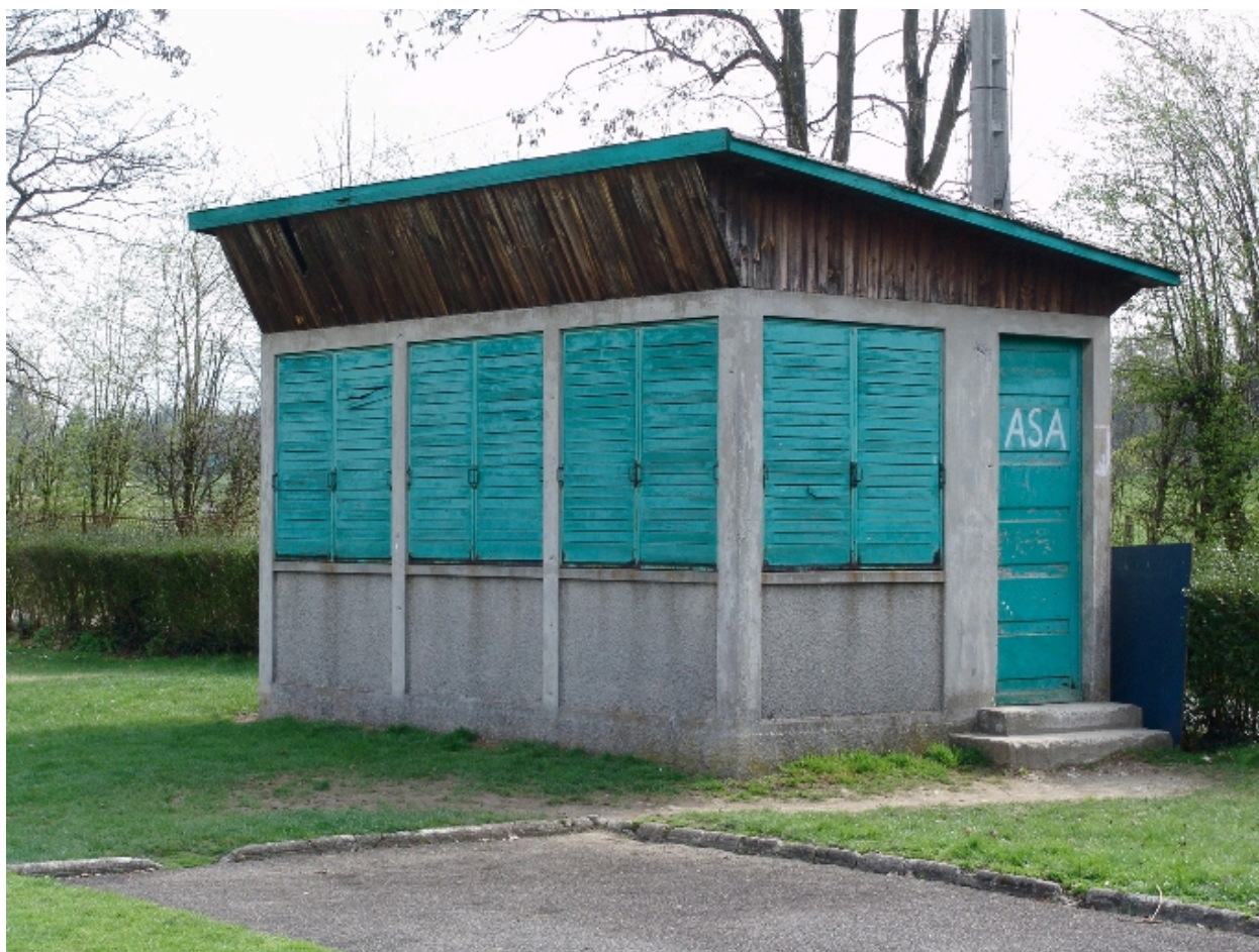
Bâtiment de chronométrage
