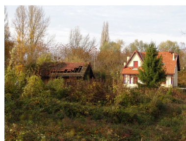
Vue dans le site Phot. François Fouger IVR82_20077300683NUCA
