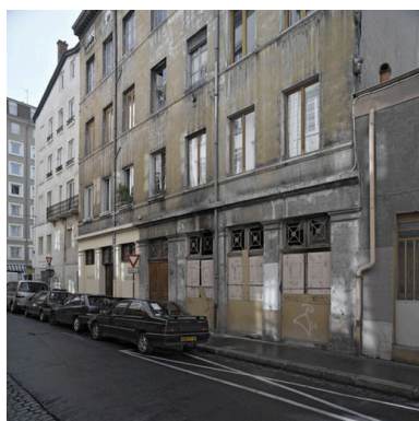
Détail du rez-de-chaussée (boutiques délimitées par des piliers monolithes). Etat en 2005 Phot. Eric Dessert IVR82_20056901610NUCA
