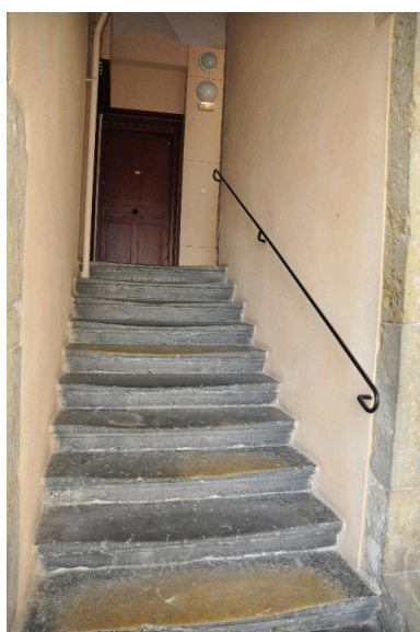
Vue de l'escalier Phot. Nadine Halitim-Dubois IVR82_20146900448NUCA
