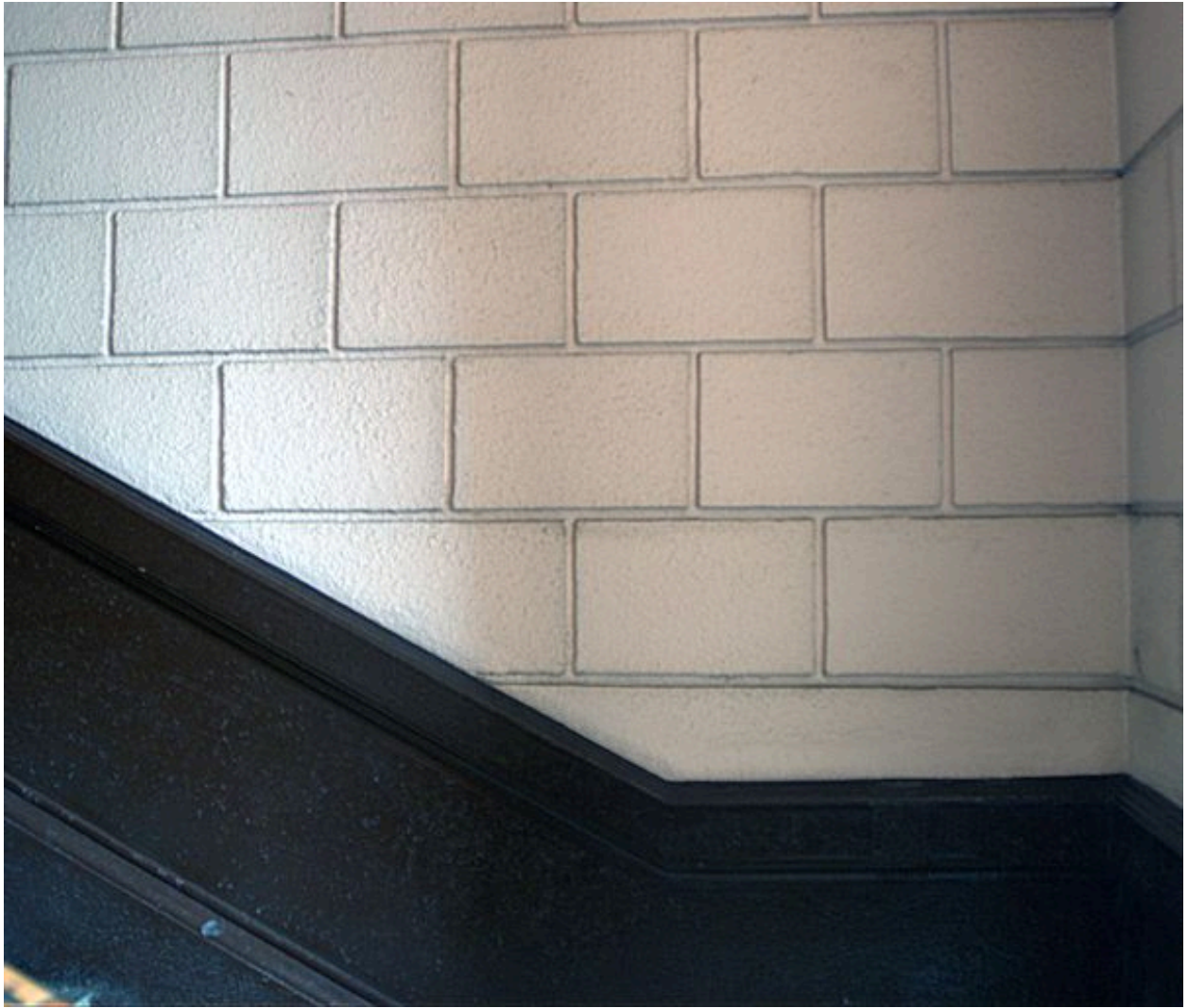
Cage d'escalier, détail
