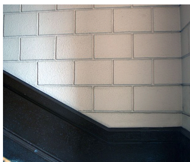
Cage d'escalier, détail Phot. Maryannick Chalabi IVR82_20116901754NUCA
