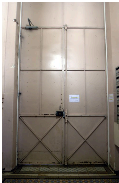
Revers de la porte d'entrée Phot. Maryannick Chalabi IVR82_20116901748NUCA
