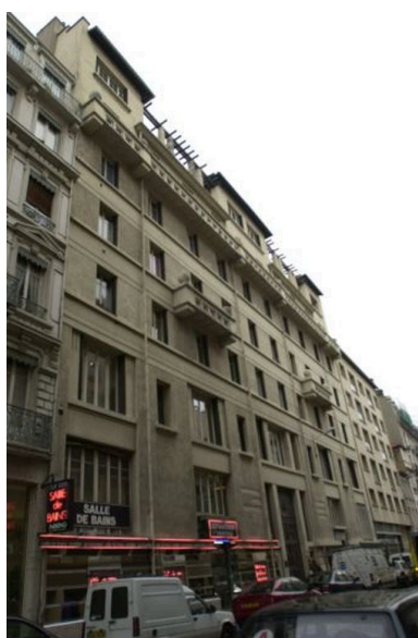
Vue générale de l'élévation Phot. Maryannick Chalabi IVR82_20046903225NUCA
