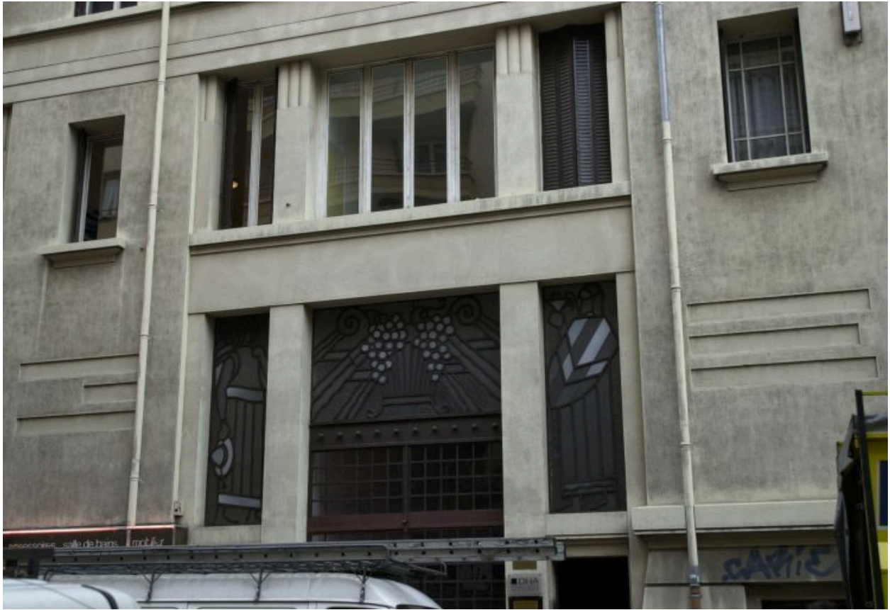
Détail de la porte d'entrée
