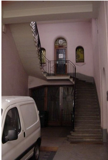
Vue du départ de l'escalier et de la loge de concierge Phot. Anaïs Beccaria IVR82_20046903545NUCA
