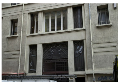
Détail de la porte d'entrée Phot. Maryannick Chalabi IVR82_20046903226NUCA
