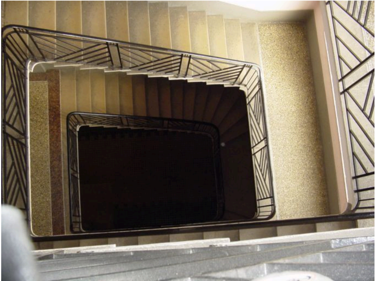
Vue de la cage d'escalier en surplomb
