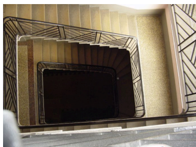
Vue de la cage d'escalier en surplomb Phot. Anaïs Beccaria IVR82_20046903547NUCA
