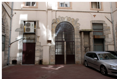
La cour : élévation est, le rez-de-chaussée Phot. Véronique Belle IVR82_20096904858NUCA
