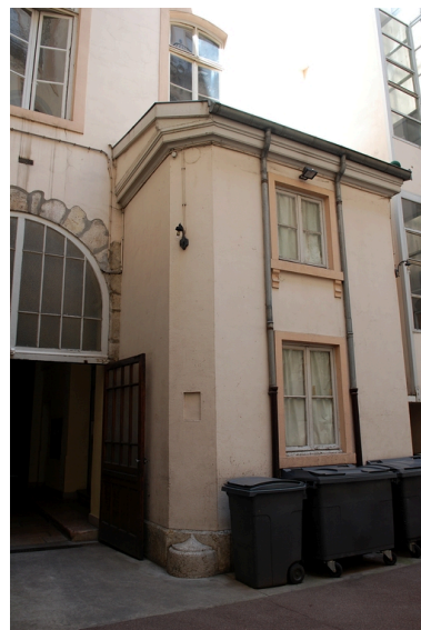
La cour : élévation ouest, loge de concierge Phot. Véronique Belle IVR82_20096904861NUCA
