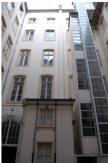
La cour : élévation ouest Phot. Véronique Belle IVR82_20096904874NUCA
