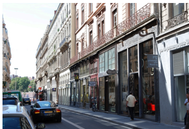
Elévation rue Gasparin : le rez-de-chaussée vers la place Bellecour Phot. Véronique Belle IVR82_20096904853NUCA
