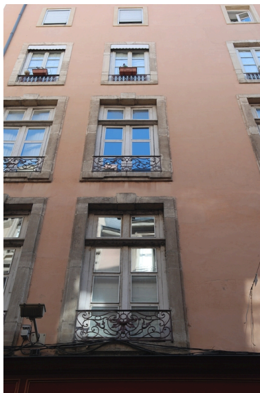
Elévation rue Emile-Zola : vue partielle Phot. Véronique Belle IVR82_20096904848NUCA
