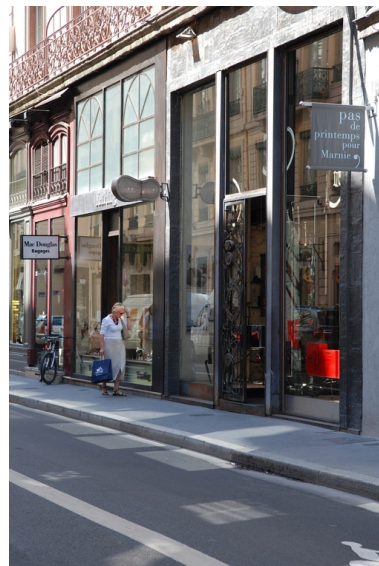
Elévation rue Gasparin : le rez-de-chaussée, détail Phot. Véronique Belle IVR82_20096904854NUCA
