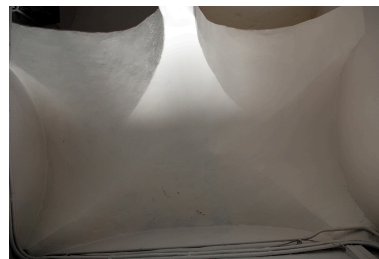
Escalier de service : couverture, berceau en plein cintre à lunettes Phot. Véronique Belle IVR82_20096904871NUCA
