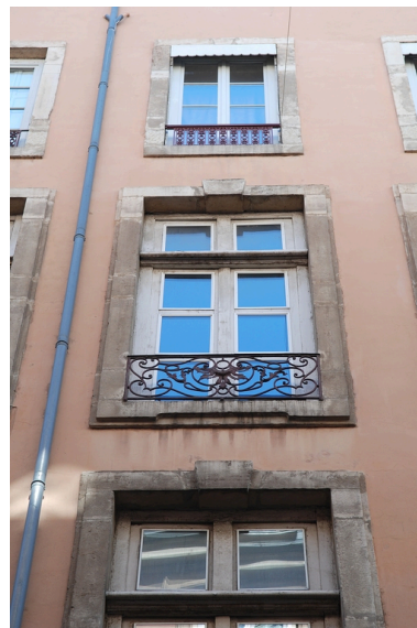
Elévation rue Emile-Zola : détail de fenêtres et de leur garde-corps Phot. Véronique Belle IVR82_20096904849NUCA
