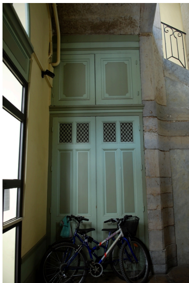
Escalier : boiseries au rez-de-chaussée Phot. Véronique Belle IVR82_20096904864NUCA
