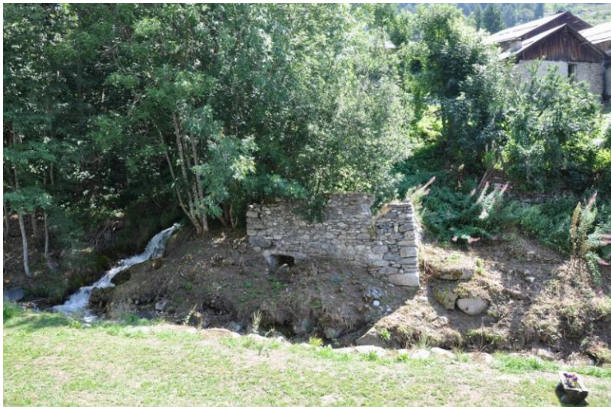
Vue du moulin du pont (moulin aval).
