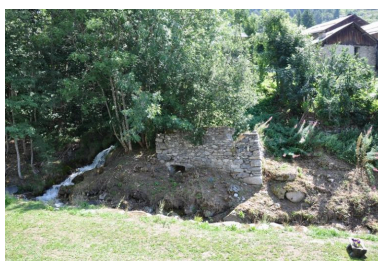
Vue du moulin du pont (moulin aval). Phot. Clara Bérelle IVR84_20167301673NUCA
