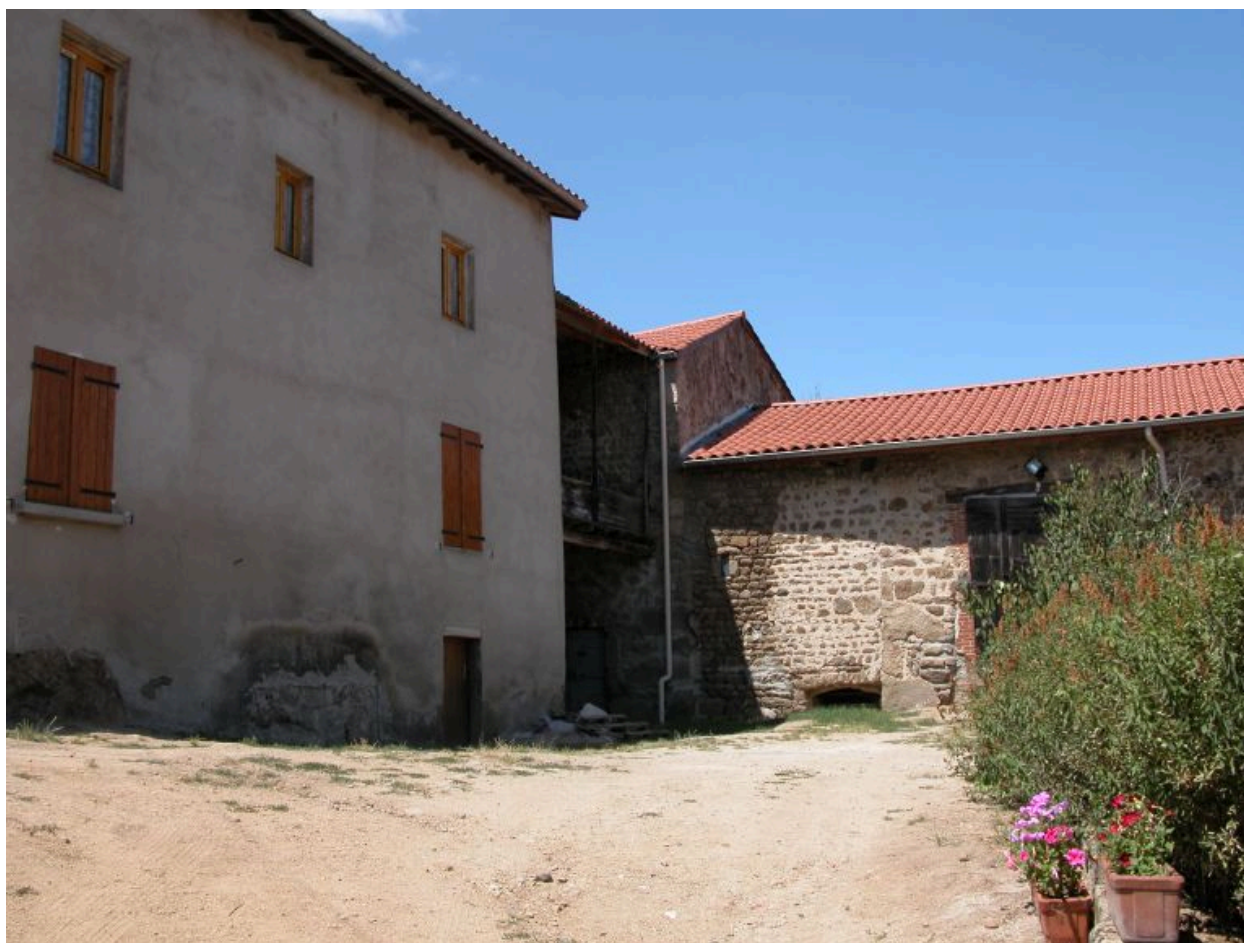
Vue d'ensemble de la grange-étable.
