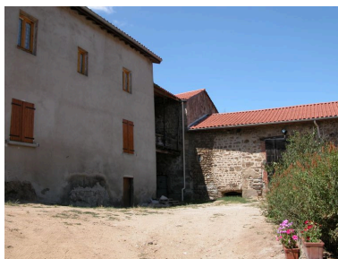
Vue d'ensemble de la grange-étable.
