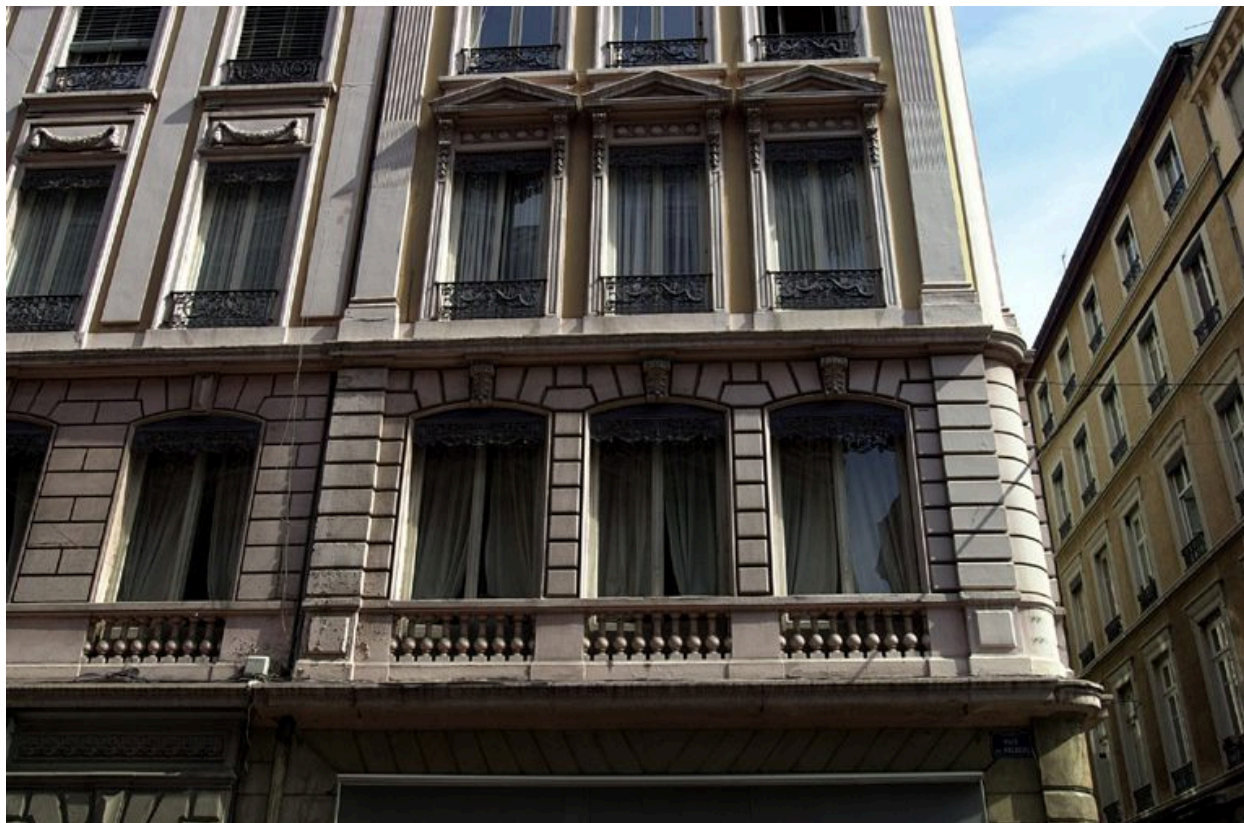
Détail des travées d'angle
