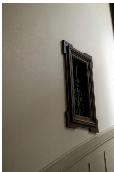
Fenêtre de second jour ouvrant sur l'escalier Phot. Véronique Belle IVR82_20066901587NUCA
