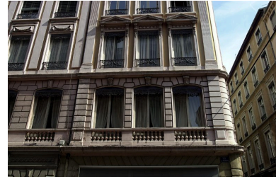
Détail des travées d'angle Phot. Véronique Belle IVR82_20066901589NUCA
