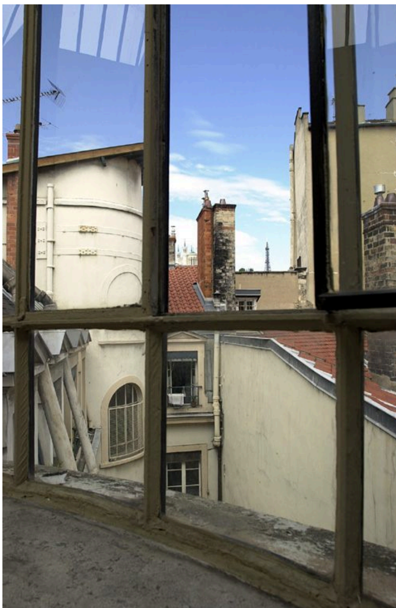
Depuis la cage d'escalier, la cour du 3 rue des Archers
