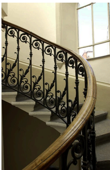
L'escalier : le garde-corps Phot. Véronique Belle IVR82_20066901591NUCA
