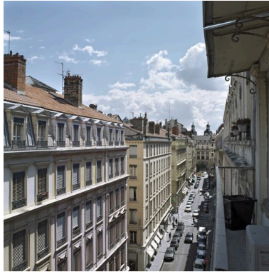
Vue partielle depuis l'immeuble sis 5 place des Célestins Phot. Eric Dessert IVR82_20066900494NUCA
