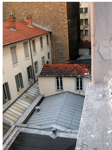
Elévation sud de la loge de concierge Phot. Maryannick Chalabi IVR82_20046904671NUCA
