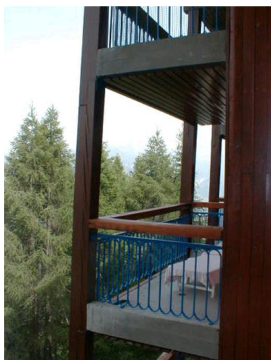
Façade ouest (aval) : détail des terrasses Phot. C. Salomon IVR82_20057301360NUCA
