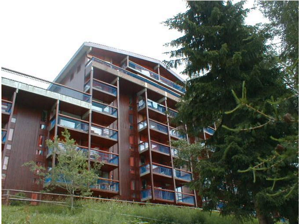
Façade ouest (aval)
