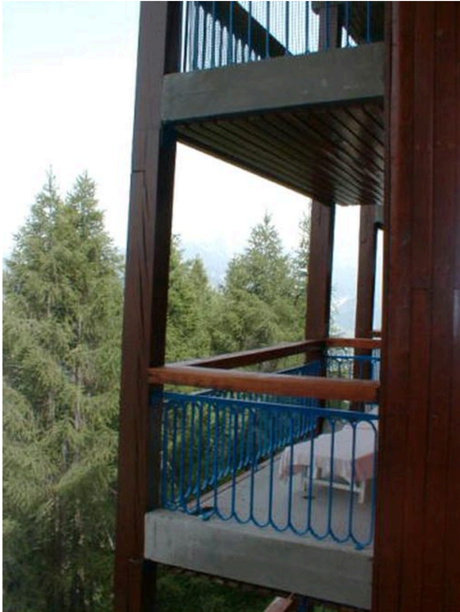
Façade ouest (aval) : détail des terrasses
