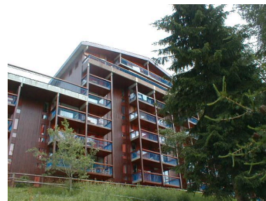
Façade ouest (aval) Phot. C. Salomon IVR82_20057301359NUCA
