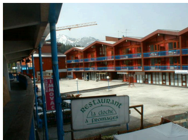
Façade est (amont) depuis la place des Arandelières Phot. C. Salomon IVR82_20057301357NUCA
