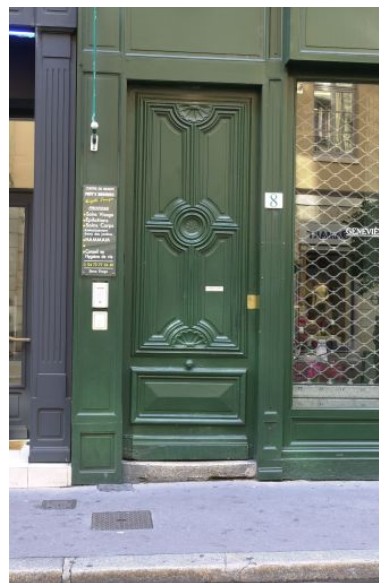
Façade, porte Phot. Bernard Ducouret IVR82_20046905794NUCA
