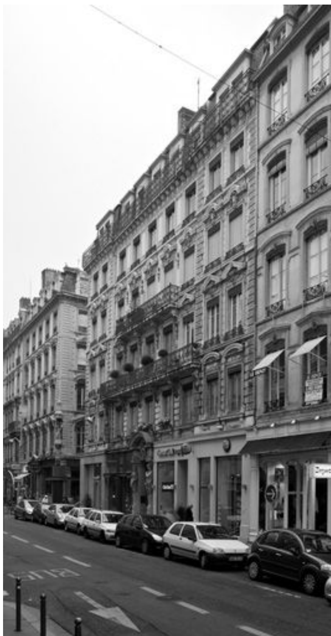
Façade principale rue du Président-Edouard-Herriot, vue générale
