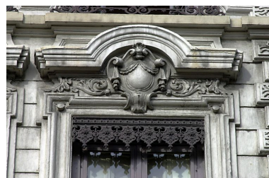
Façade principale, 4e niveau, détail d'une fenêtre des avant-corps latéraux Phot. Bernard Ducouret IVR82_20046900280NUCA
