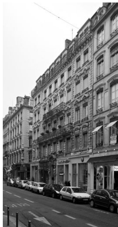
Façade principale rue du Président- Edouard-Herriot, vue générale Phot. Eric Dessert IVR82_20056901670NUC
