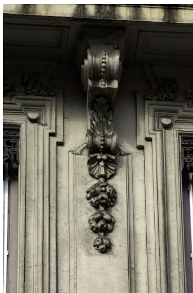
Façade principale, 3e niveau, détail d'une console de balcon Phot. Bernard Ducouret IVR82_20046900278NUCA
