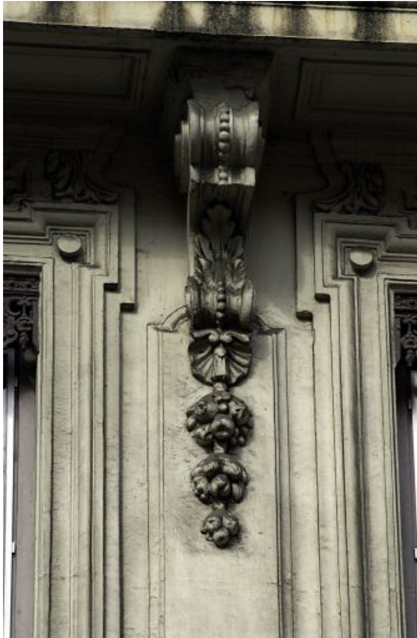
Façade principale, 3e niveau, détail d'une console de balcon
