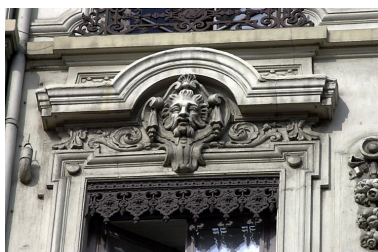
Façade principale, 4e niveau, détail d'une fenêtre des travées centrales Phot. Bernard Ducouret IVR82_20046900279NUCA
