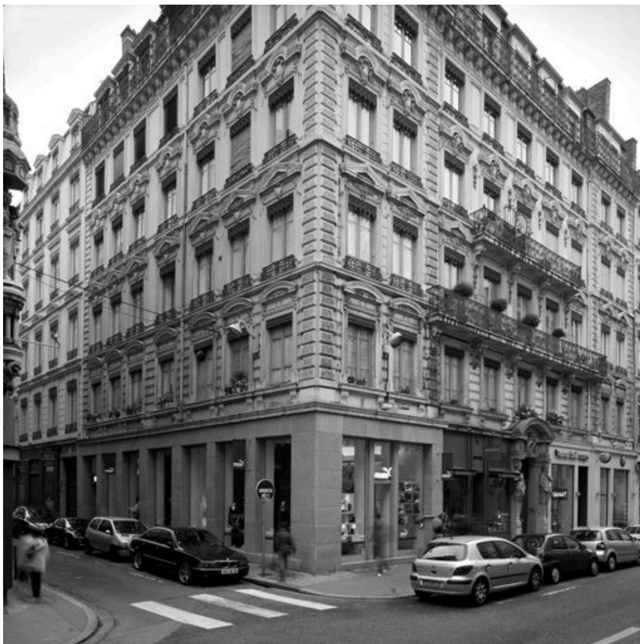
Vue générale des façades
