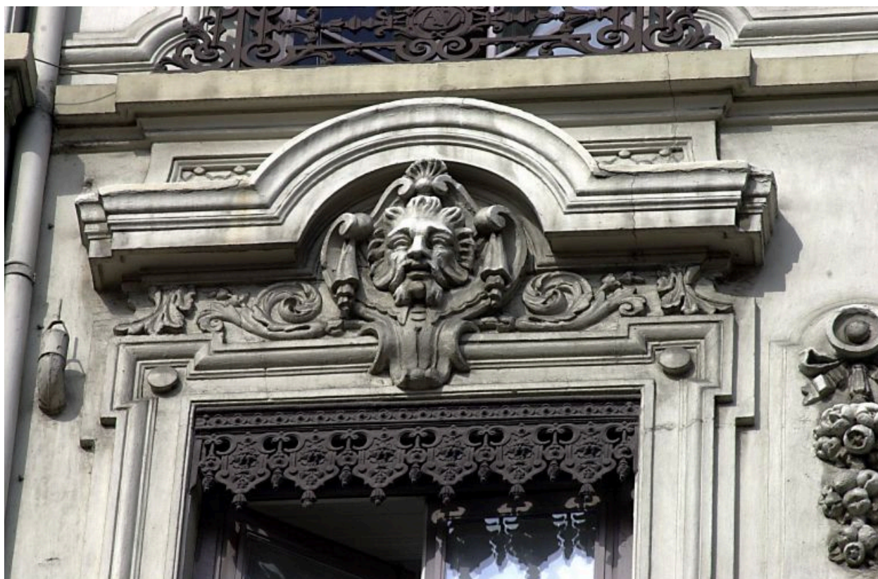
Façade principale, 4e niveau, détail d'une fenêtre des travées centrales
