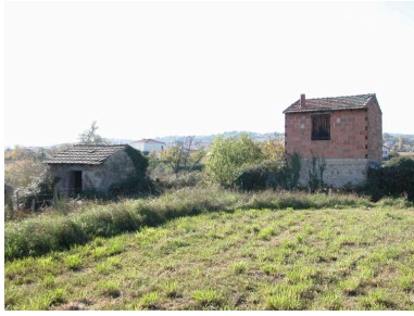
Vue générale Phot. Thierry Monnet IVR82_20134200318NUCA
