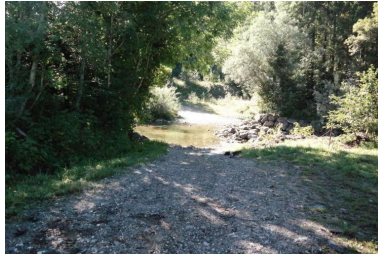
Passage à gué du Cerny, depuis la rive droite du Brevon Phot. Pascale Renard IVR84_20207401536NUCA
