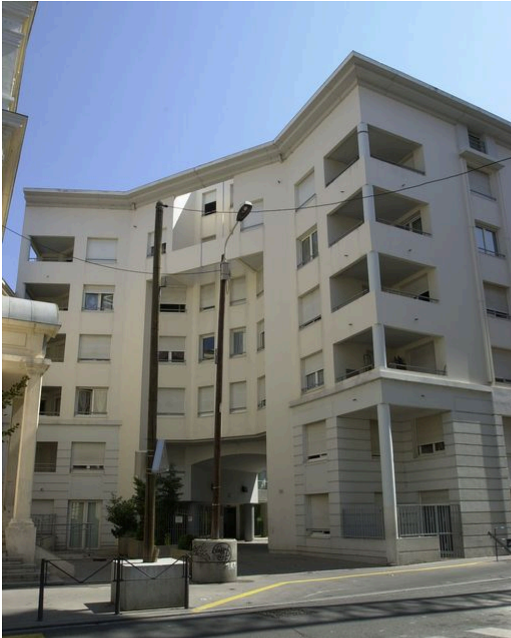
Elévation principale, passage couvert vers le square en coeur d'îlot
