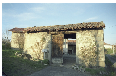
Vue du passage couvert depuis de chemin. Phot. Thierry Monnet IVR82_20044200695ZE
