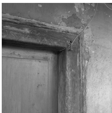
Logis, détail de l'encadrement mouluré de la porte d'entrée du logis. Phot. Jean-Marie Refflé IVR82_20024200963X
