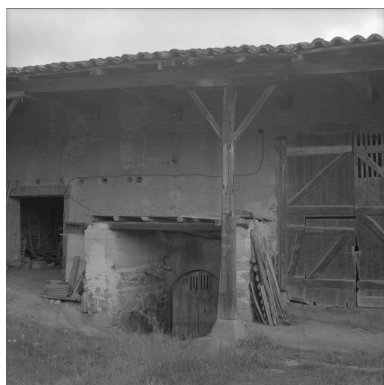
Grange-étable, porte d'entrée de la cave voûtée. Phot. Jean-Marie Refflé IVR82_20024200968X
