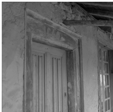
Logis, détail de la porte de l'étage, linteau daté 1640. Phot. Jean-Marie Refflé IVR82_20024200966X
