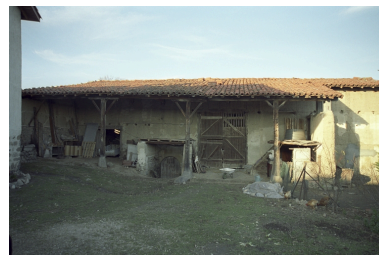
Vue d'ensemble de la grange-étable. Phot. Thierry Monnet IVR82_20044200698ZE
