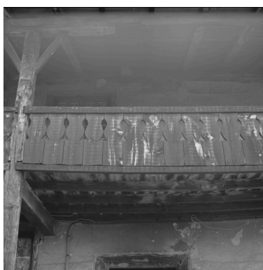
Logis, détail de la galerie en bois découpé. Phot. Jean-Marie Refflé IVR82_20024200964X
