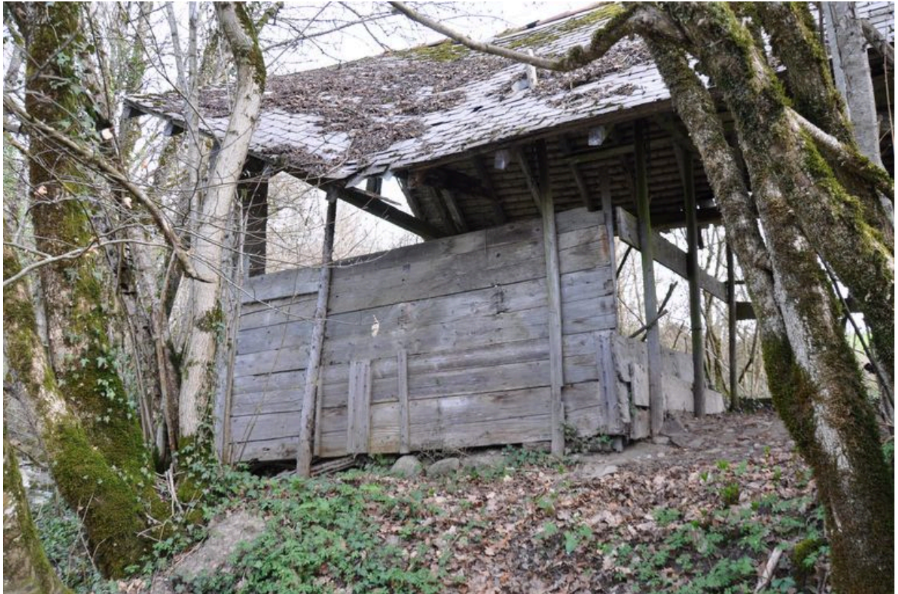
Détail d'un des murs gouttes du battoir
