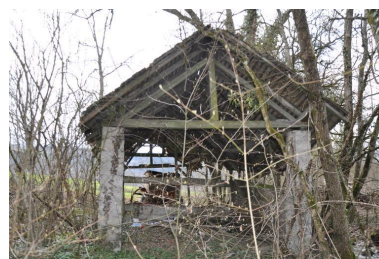
Elévation nord ouest du battoir Phot. Samir Mahfoudi, Autr. Samir Mahfoudi IVR82_20107400155NUCA
