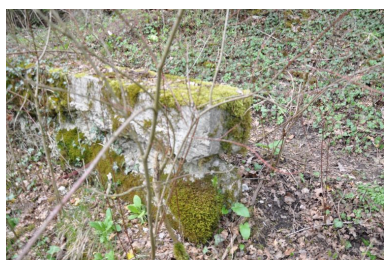
Ruines du seuil du barrage alimentant le bief des moulins Mugnier et Romand Phot. Samir Mahfoudi, Autr. Samir Mahfoudi IVR82_20107400153NUCA
