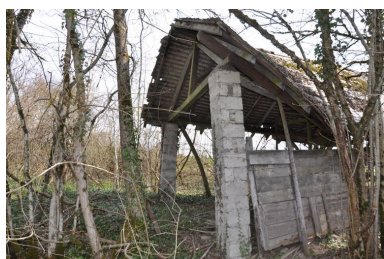
Piliers supportant la structure en bois du battoir Phot. Samir Mahfoudi, Autr. Samir Mahfoudi IVR82_20107400158NUCA
