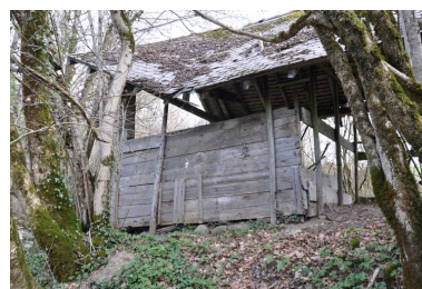
Détail d'un des murs gouttes du battoir Phot. Samir Mahfoudi, Autr. Samir Mahfoudi IVR82_20107400157NUCA
