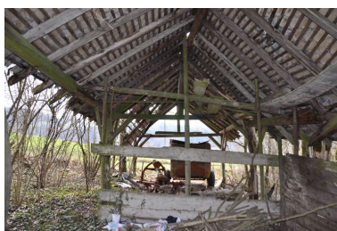
Vue intérieure du battoir Phot. Samir Mahfoudi, Autr. Samir Mahfoudi IVR82_20107400156NUCA
