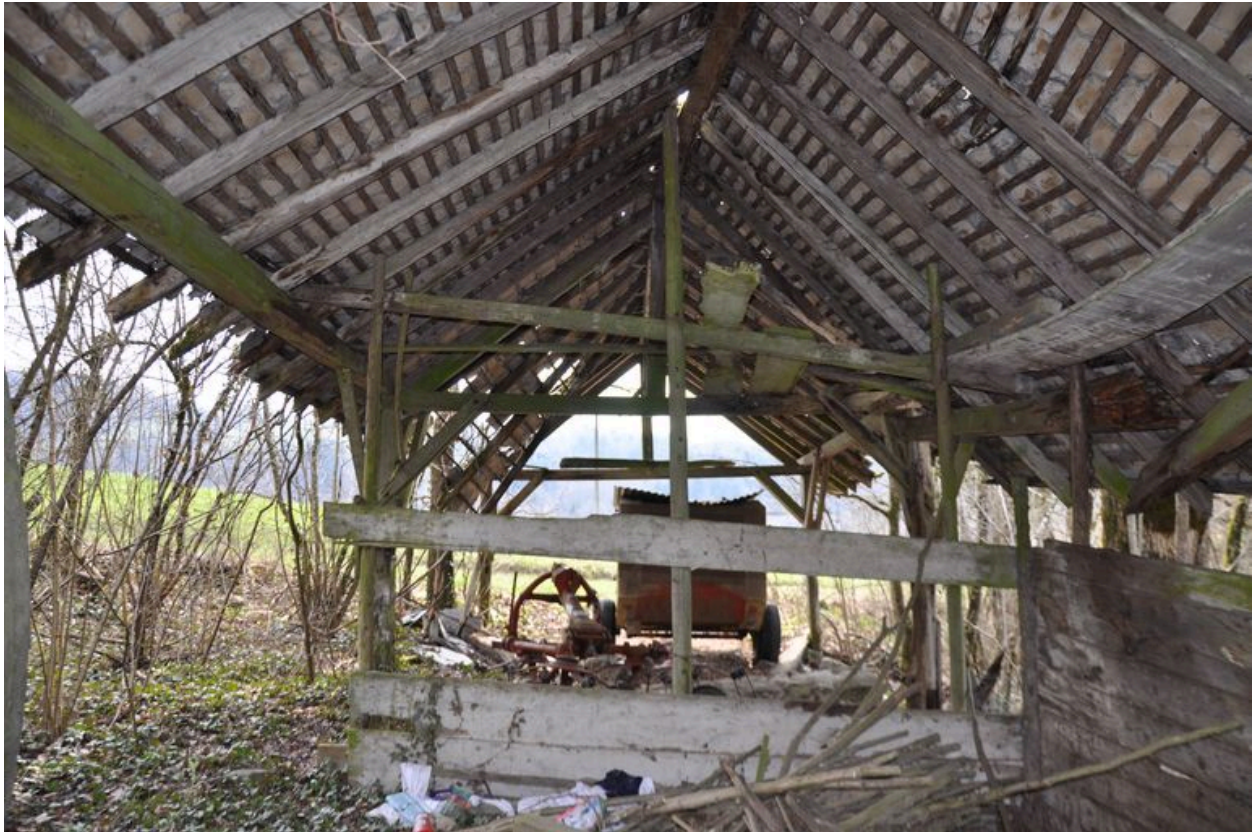
Vue intérieure du battoir
