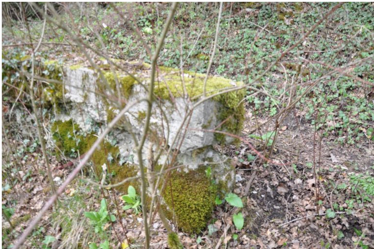
Ruines du seuil du barrage alimentant le biefs des moulins Mugnier et Romand
