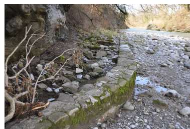
Mur du canal de fuite Phot. Samir Mahfoudi, Autr. Samir Mahfoudi IVR82_20107400237NUCA
