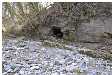
Vue du bief sous-terrain prise depuis les bancs de pierre de la rive gauche du Fier Phot. Samir Mahfoudi, Autr. Samir Mahfoudi IVR82_20107400235NUCA
