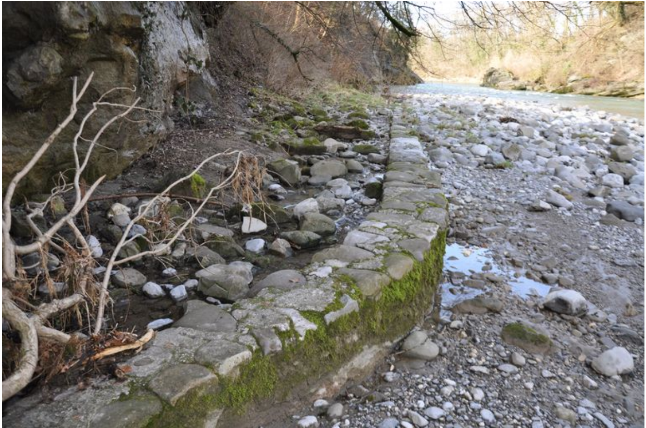
Mur du canal de fuite
