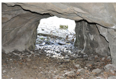
Vue intérieure du canal sous terrain Phot. Samir Mahfoudi, Autr. Samir Mahfoudi IVR82_20107400236NUCA
