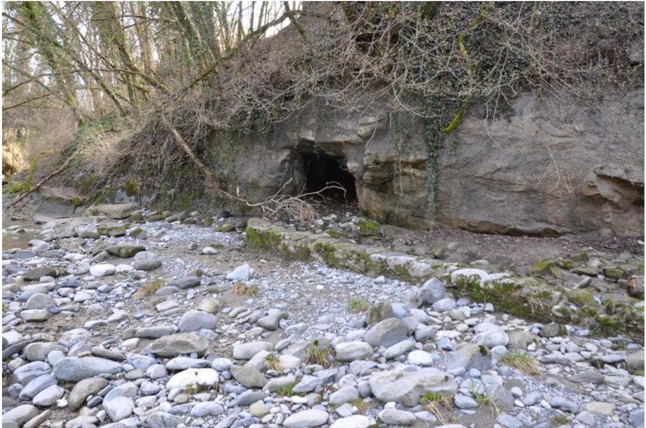
Vue du bief sous-terrain prise depuis les bancs de pierre de la rive gauche du Fier
