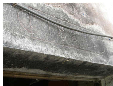
Vue d'un linteau daté (1881) sur une ferme abandonnée (2008 F10 1285). Phot. Jérôme Daviet IVR82_20137401811NUCA
