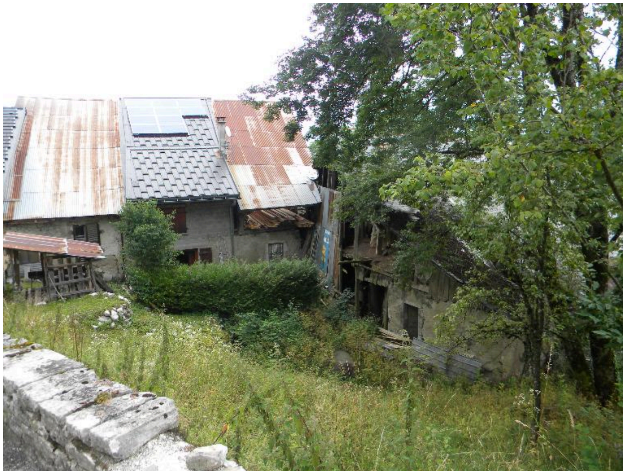
Vue des façades arrières d'un alignement de fermes.(2008 F10 1286, 1287, 1288)
