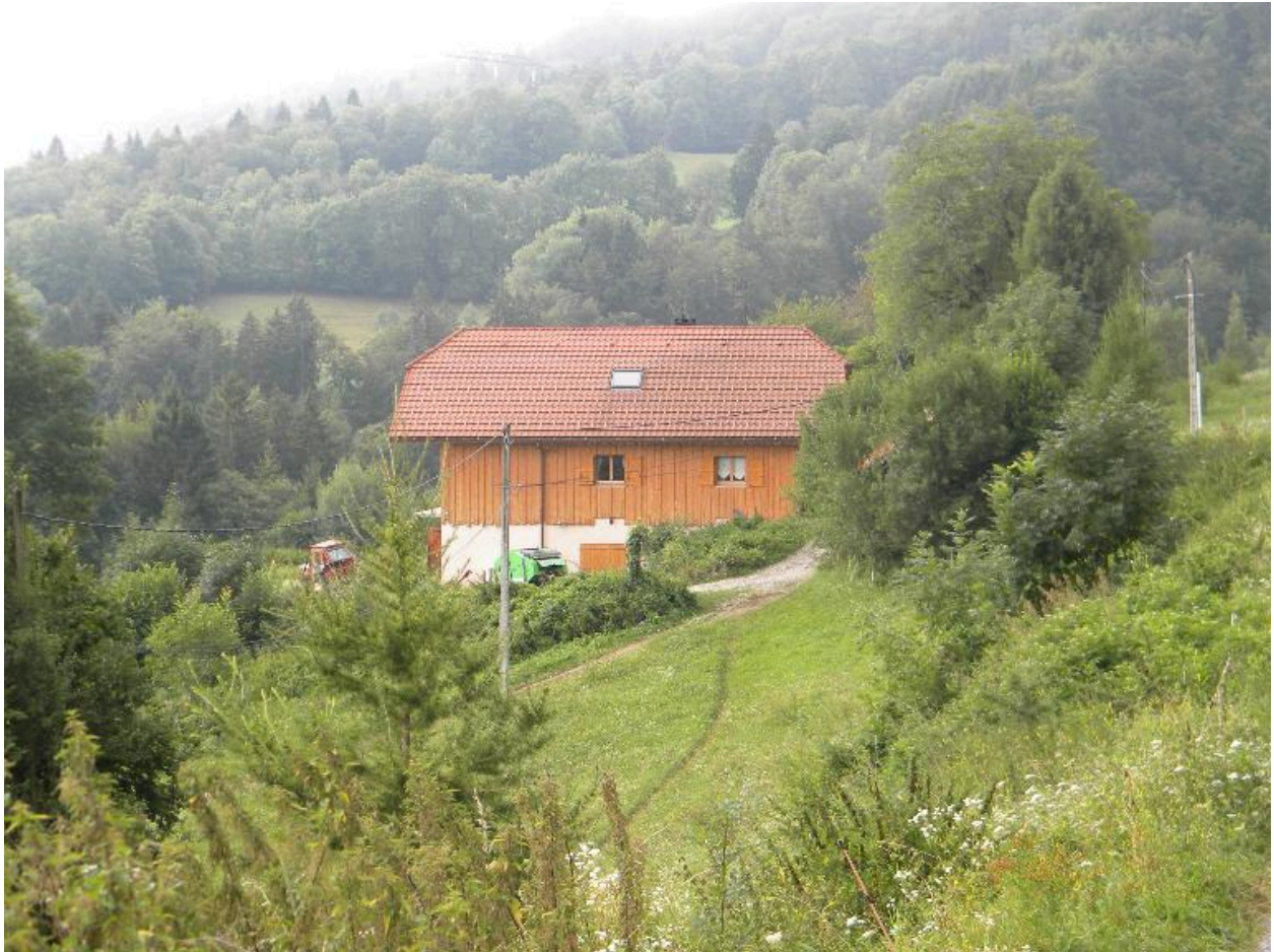
Vue d'ensemble d'une ferme modifiée au sud du hameau (2008 F10 2389).
