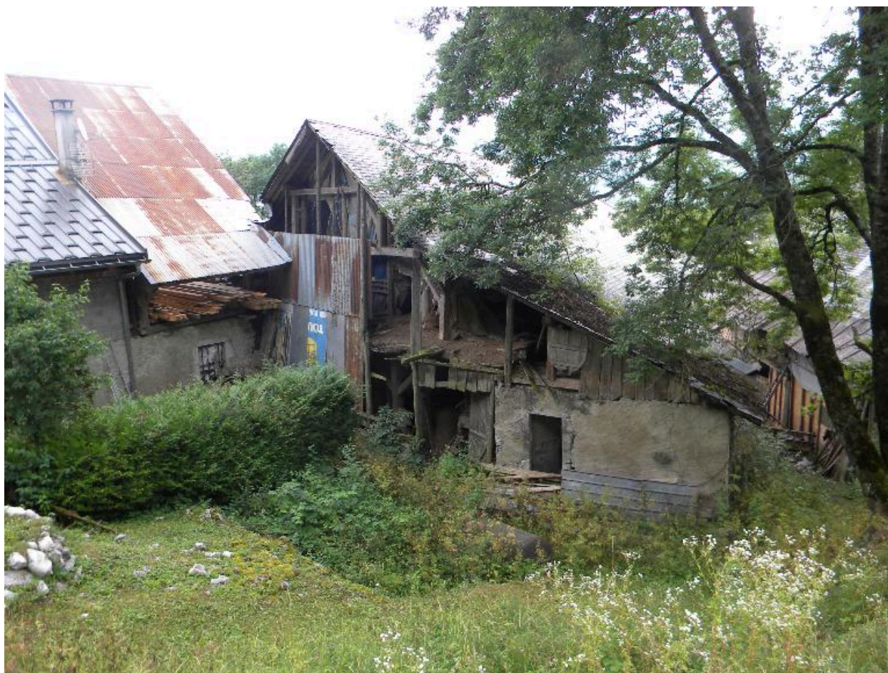
Vue de la façade arrière d'une ferme abandonnée (2008 F10 1285).
