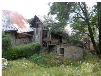
Vue de la façade arrière d'une ferme abandonnée (2008 F10 1285). Phot. Jérôme Daviet IVR82_20137401812NUCA
