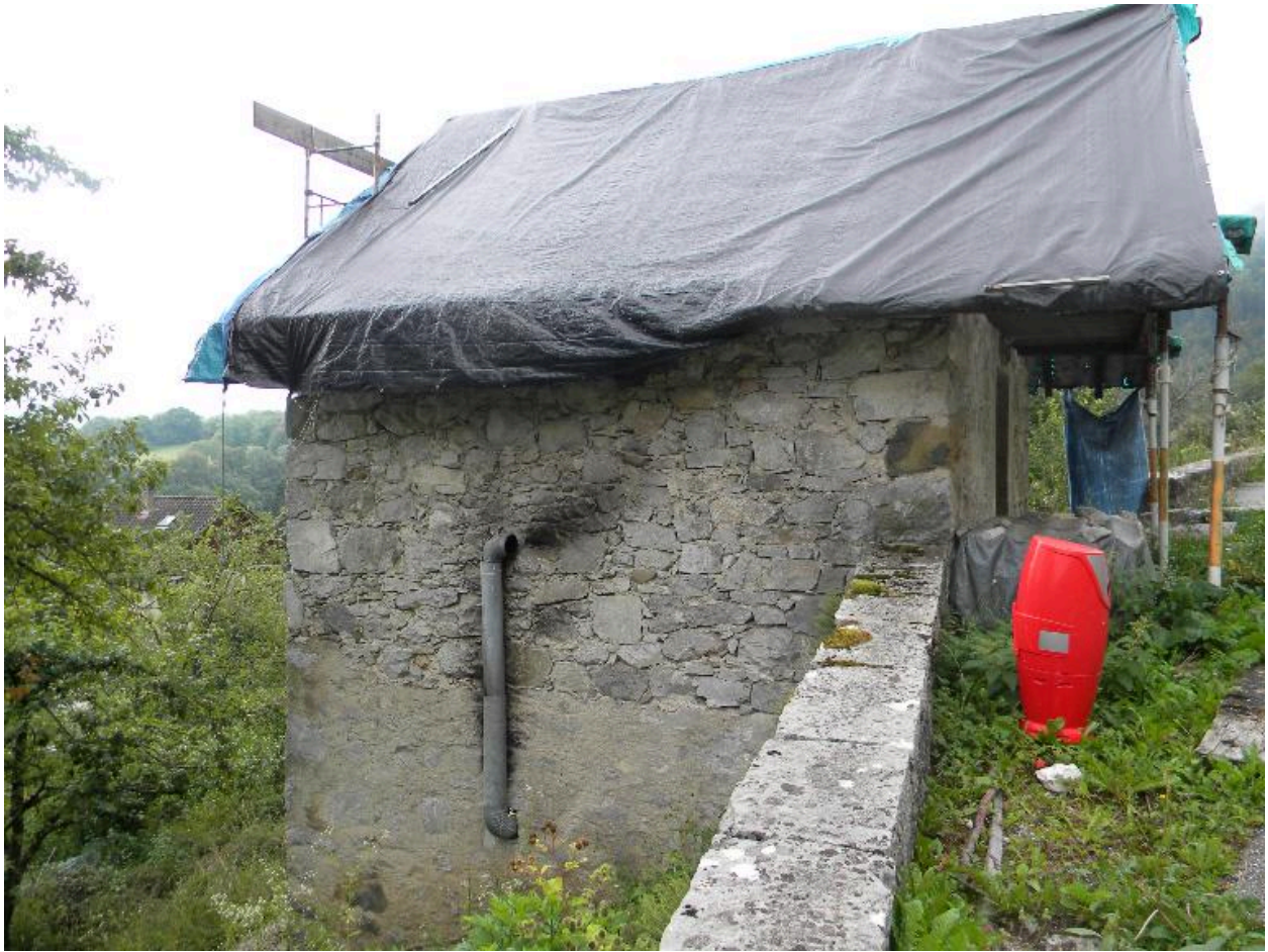
Vue du pignon nord d'une maison abandonnée (2008 F10 1281)
