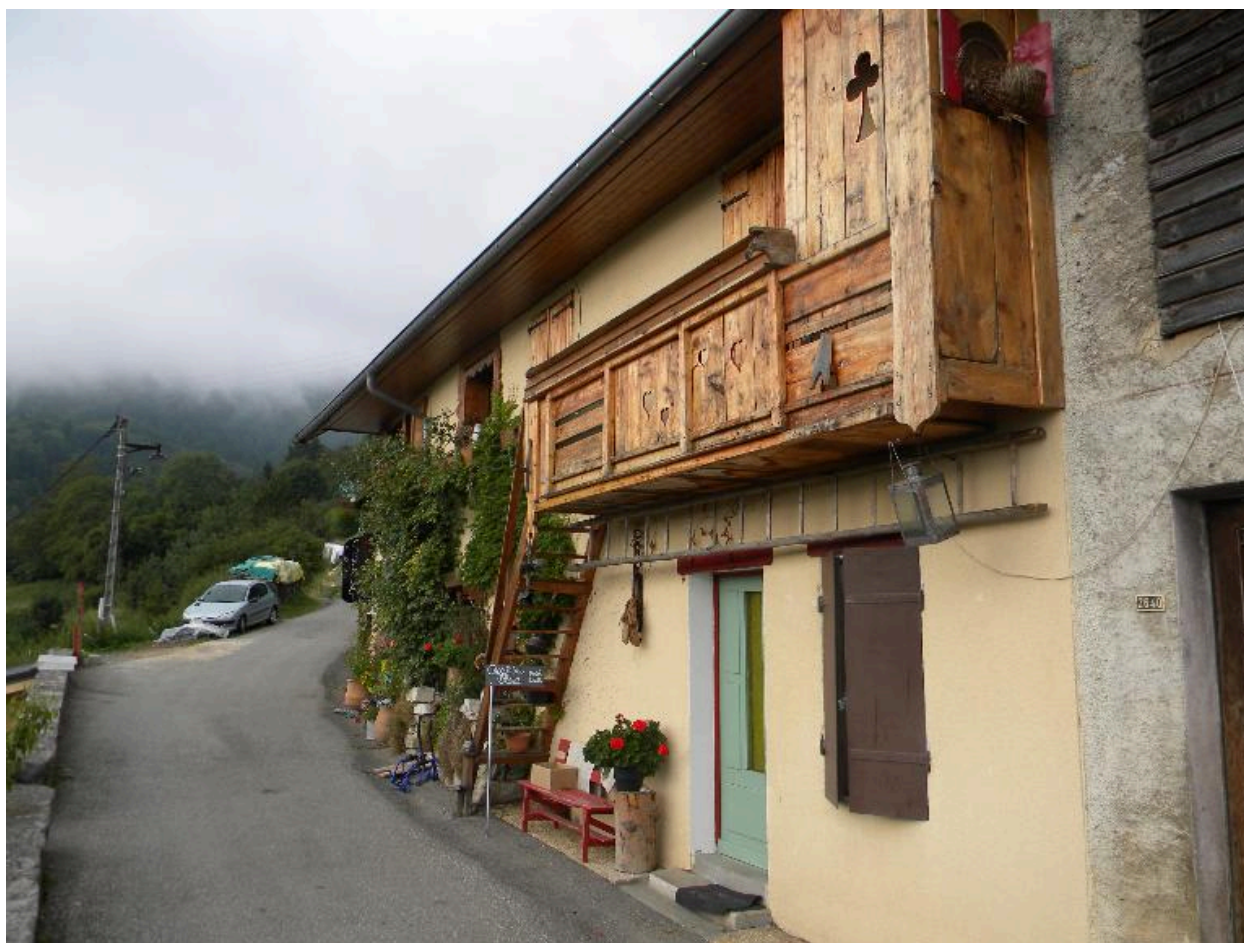
Façade d'une ferme remaniée à l'entrée sud du hameau (2008 F10 1315).
