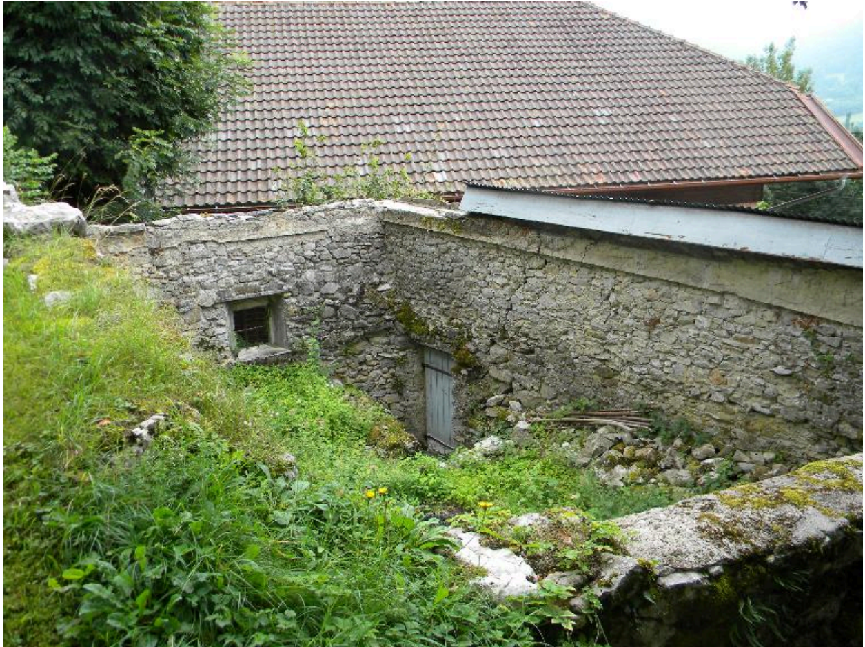
Vue d'une maison en ruine (2008 F10 1298).
