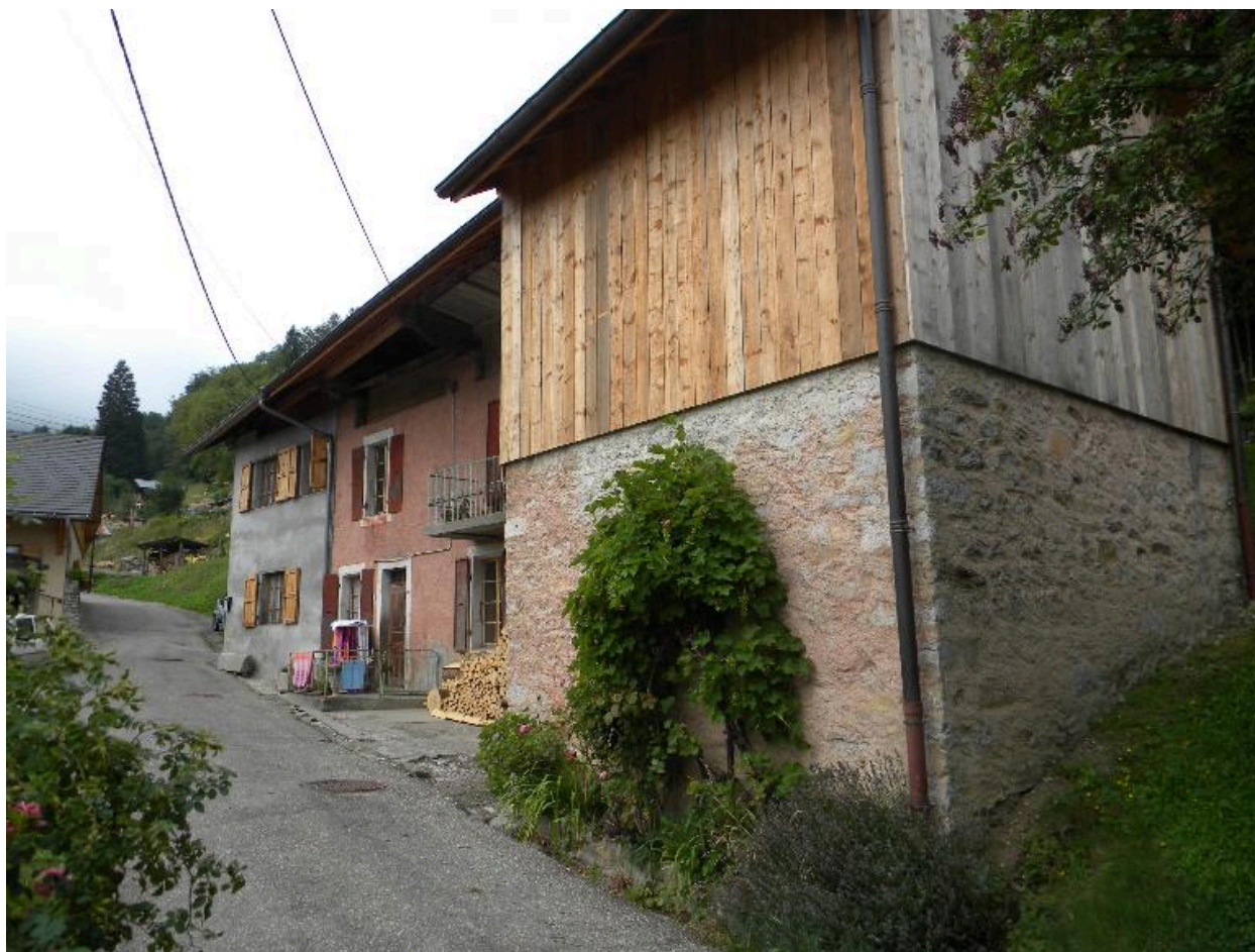
Vue de trois-quarts d'une ferme à juxtaposition (2008 F10 1305).
