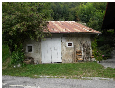
Vue d'un hangar construit contre une maison en ruine (2008 F10 1290) Phot. Jérôme Daviet IVR82_20137401816NUCA
