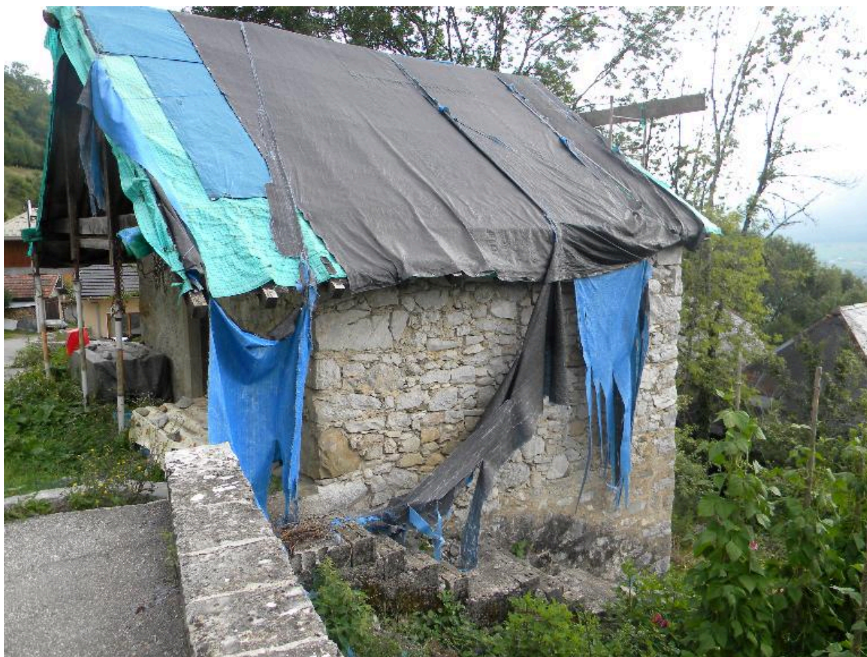
Vue du pignon sud d'une maison abandonnée (2008 F10 1281)
