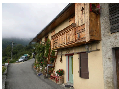
Façade d'une ferme remaniée à l'entrée sud du hameau (2008 F10 1315). Phot. Jérôme Daviet IVR82_20137401172NUCA
