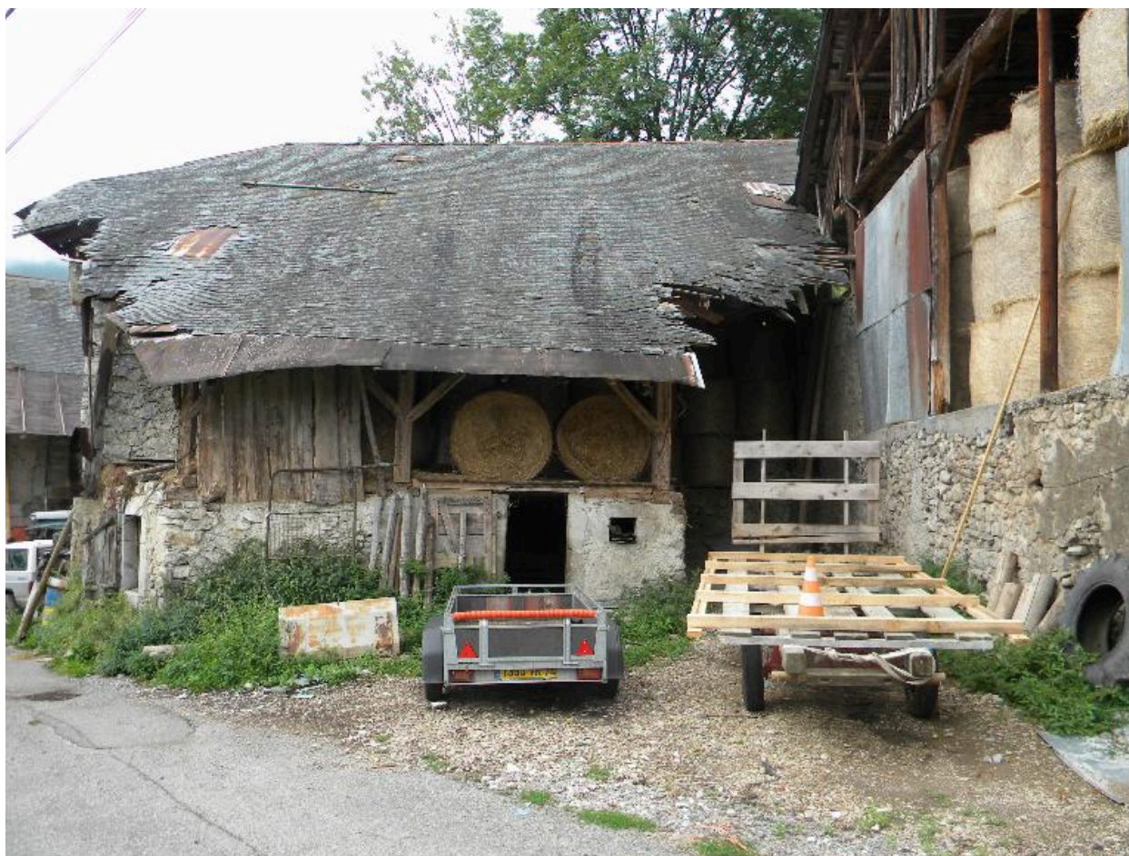
Vue de la façade nord d'une ferme abandonnée (2008 F10 1285)
