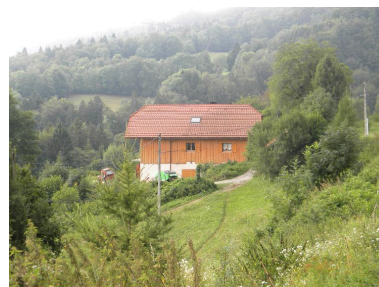
Vue d'ensemble d'une ferme modifiée au sud du hameau (2008 F10 2389). Phot. Jérôme Daviet IVR82_20137401171NUCA
