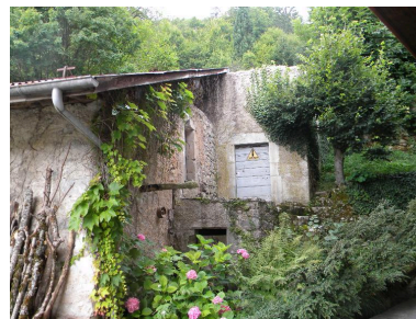
Vue d'une maison en ruine avec un appenti appuyé sur les vestiges. (2008 F10 1298). Phot. Jérôme Daviet IVR82_20137401817NUCA
