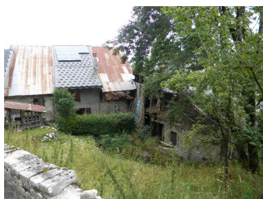
Vue des façades arrières d'un alignement de fermes. (2008 F10 1286, 1287, 1288) Phot. Jérôme Daviet IVR82_20137401803NUCA
