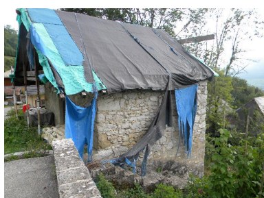
Vue du pignon sud d'une maison abandonnée (2008 F10 1281) Phot. Jérôme Daviet IVR82_20137401175NUCA
