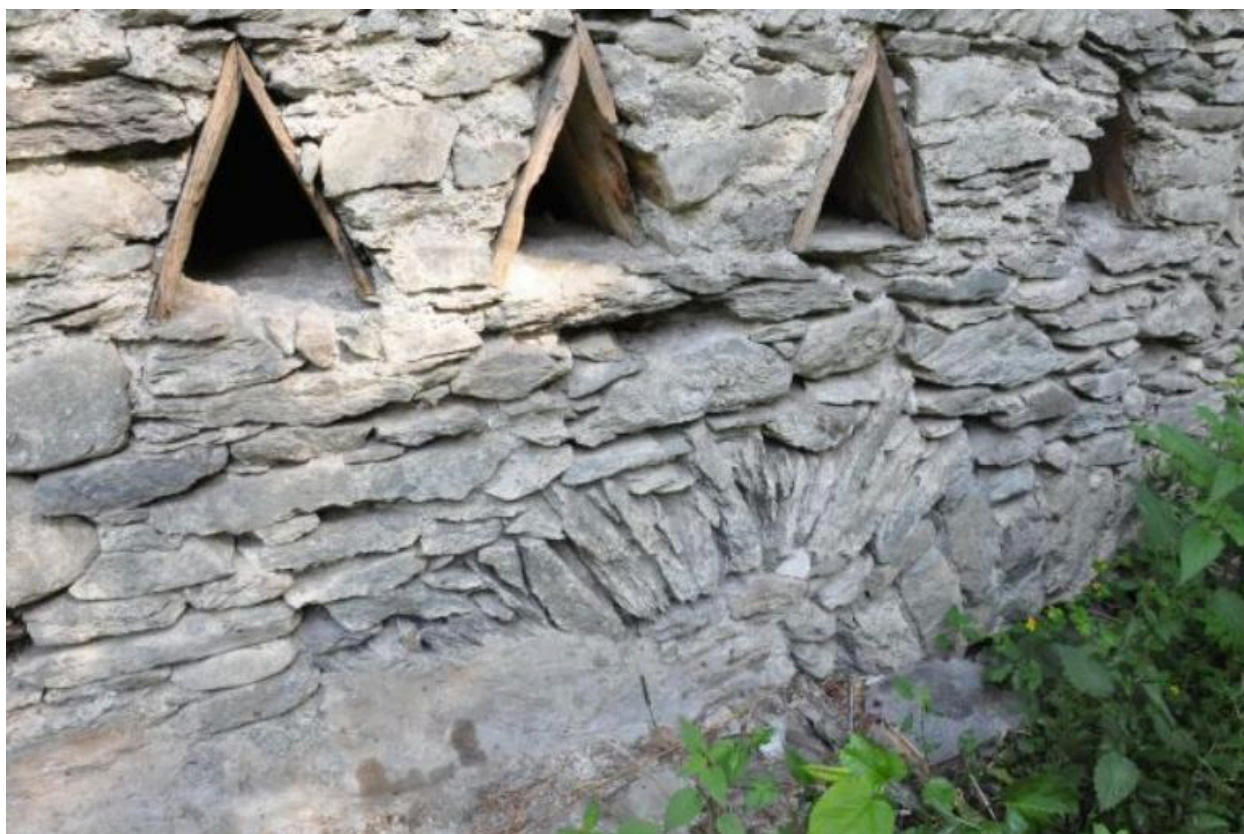
Détail du mur sud-est du moulin avec l'arrivée voûtée du canal de dérivation aujourd'hui condamnée.
