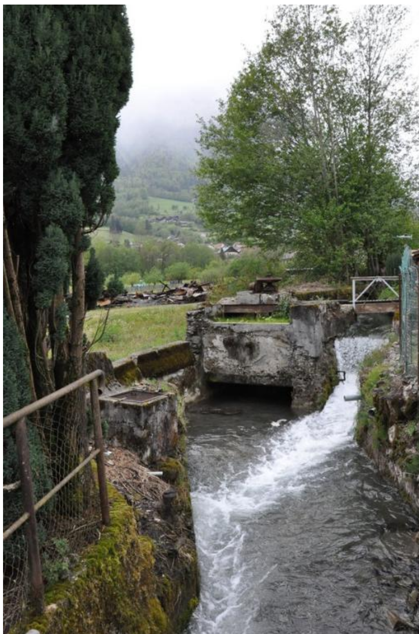
Vestiges du site implanté sur la dérivation.
