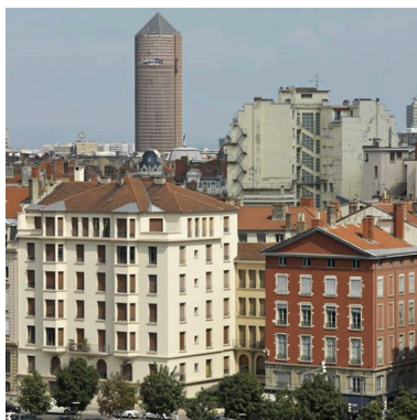
Vue de situation depuis la toiture de la cathédrale Saint-Jean : élévation postérieure et cage d'escalier Phot. Eric Dessert IVR82_20066900567NUCA
