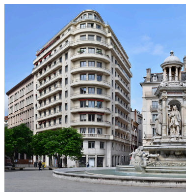
Vue générale Phot. Thierry Leroy IVR84_20266900407NUCAQ
