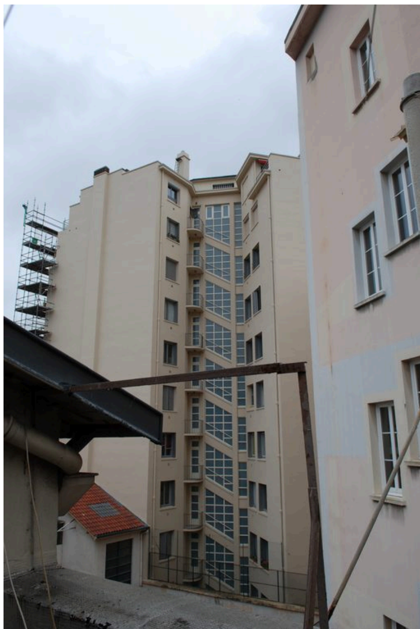
Elévation sur cour et murs pignon depuis une terrasse du groupe scolaire Lamartine
