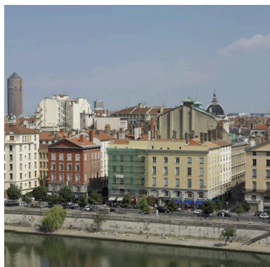
Vue de situation depuis la toiture de la cathédrale Saint-Jean : élévation postérieure et cage d'escalier Phot. Eric Dessert IVR82_20066900563NUCA
