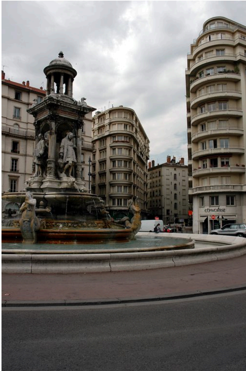
Vue de situation depuis la place des Jacobins : l'immeuble se trouve à droite
