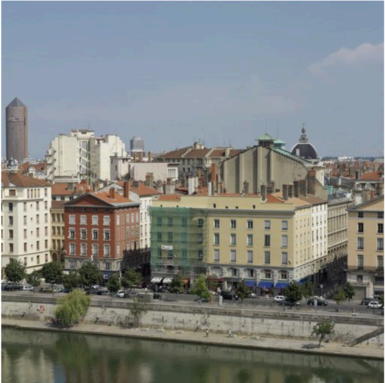
Vue de situation depuis la toiture de la cathédrale Saint-Jean : élévation postérieure et cage d'escalier
