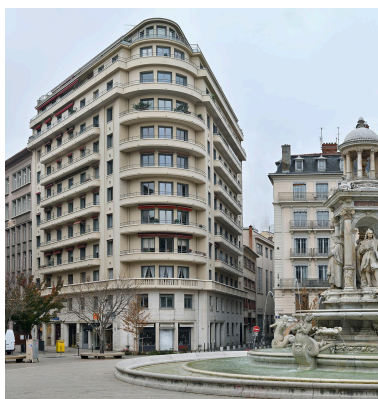
Vue générale Phot. Thierry Leroy IVR84_20256901866NUCAQ
