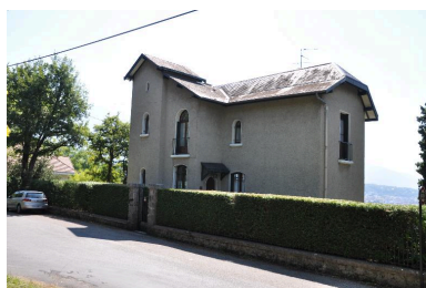
Vue de trois-quart droite Phot. Denys Harreau IVR82_20137300810NUCA
