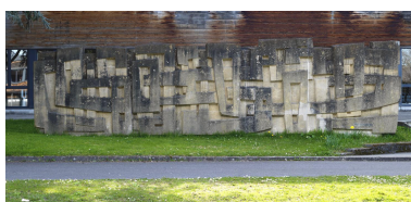
Vue de face. Phot. Franck Trabouillet IVR84_20217400324NUCA
