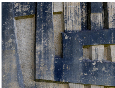
Détail. Phot. Franck Trabouillet IVR84_20217400318NUCA
