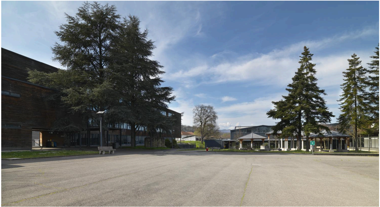
Vue générale, dans son environnement.
