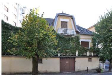
Façade sur rue Phot. François Fouger IVR82_20097301074NUCA
