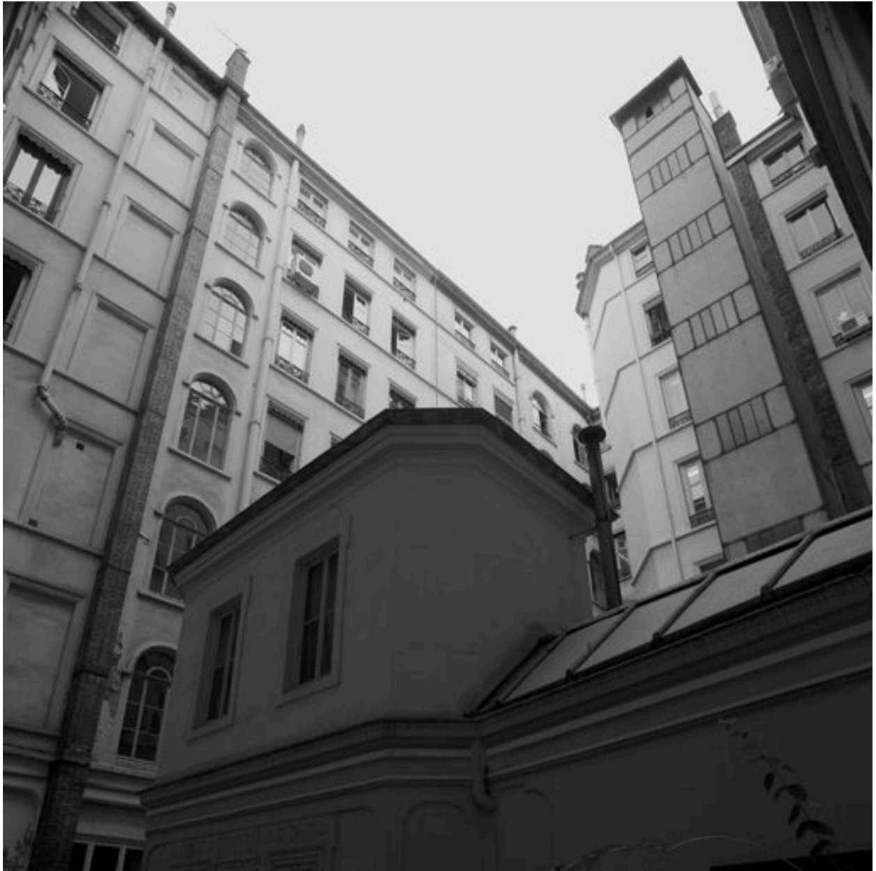
Vue de la conciergerie depuis le sud-est
