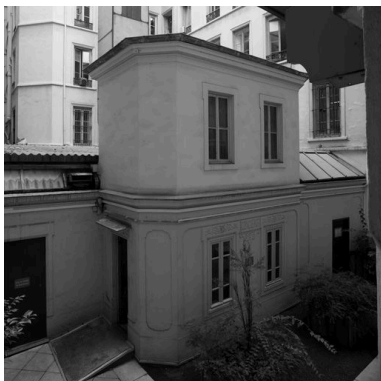
Vue de la conciergerie construite dans la cour Phot. Eric Dessert IVR82_20046901097NUC
