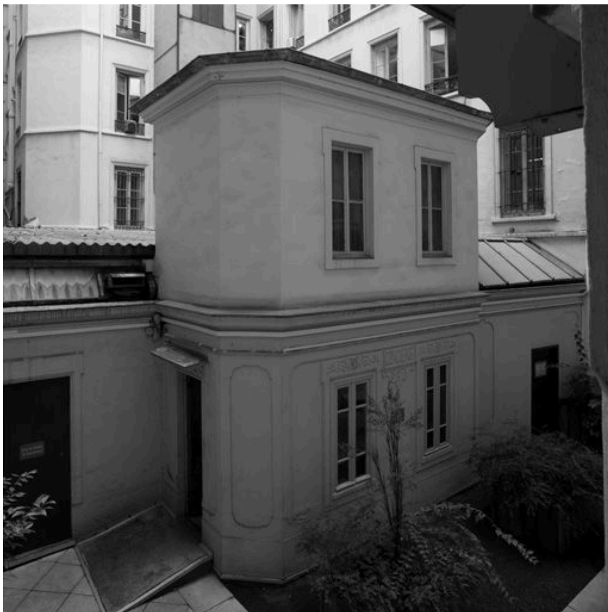
Vue de la conciergerie construite dans la cour
