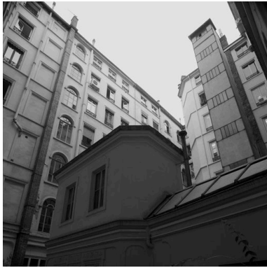
Vue de la conciergerie depuis le sud-est Phot. Eric Dessert IVR82_20046901114NUC
