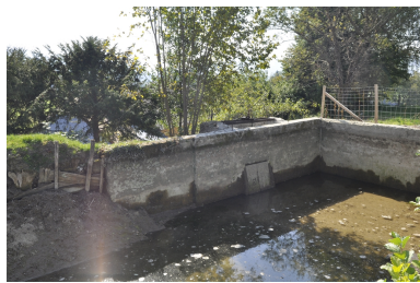
Vue de la retenue côté aval. Phot. Caroline Guibaud IVR82_20157402872NUCA
