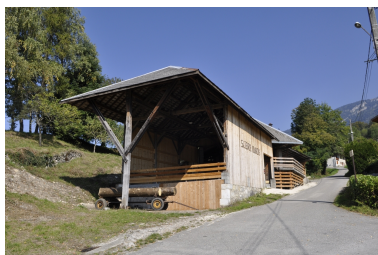
Vue d'ensemble depuis le sud-ouest (en 2015). Phot. Caroline Guibaud IVR82_20157402861NUCA
