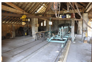
Vue d'ensemble intérieure. Phot. Caroline Guibaud IVR82_20157402868NUCA
