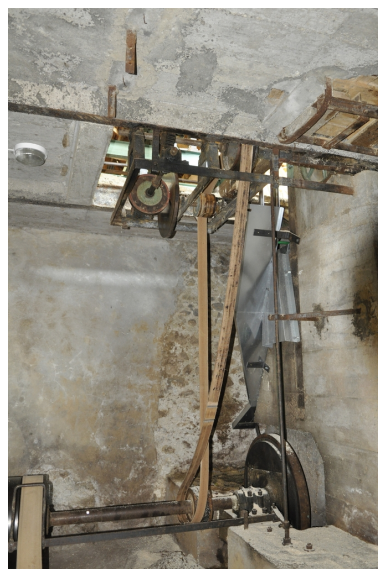
Vue du moteur électrique et des systèmes d'entraînement. Phot. Caroline Guibaud IVR82_20157402865NUCA
