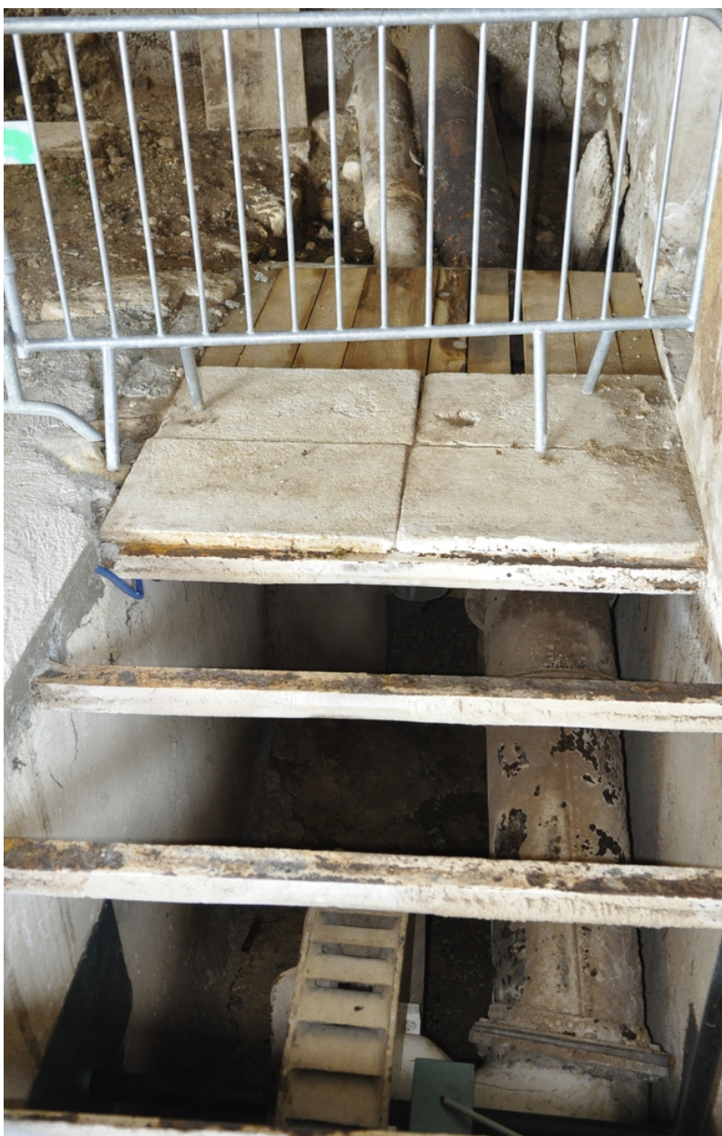
Vue de la conduite forcée et de la roue hydraulique.
