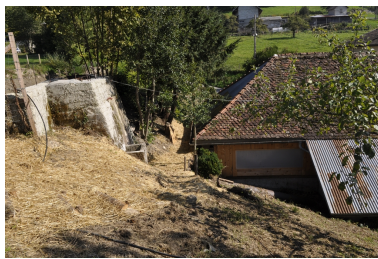
Mur de la retenue et vue arrière de la scierie. Phot. Caroline Guibaud IVR82_20157402873NUCA
