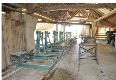
Vue d'ensemble intérieure. Phot. Caroline Guibaud IVR82_20157402869NUCA
