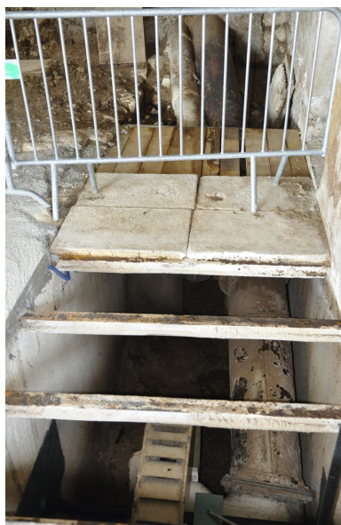
Vue de la conduite forcée et de la roue hydraulique. Phot. Caroline Guibaud IVR82_20157402862NUCA
