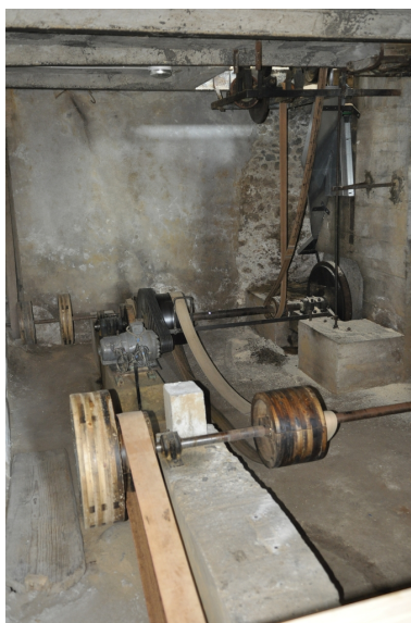
Vue du moteur électrique et des systèmes d'entraînement. Phot. Caroline Guibaud IVR82_20157402863NUCA
