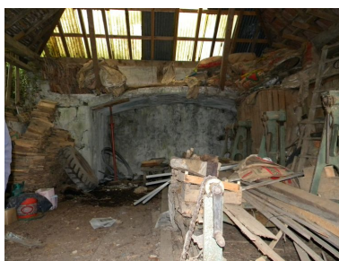
Vue de la partie maçonnée plus ancienne au fond de la scierie. Phot. Jérôme Daviet IVR82_20127400718NUCA
