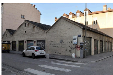
Façade arrière des ateliers sur la rue d'Anvers Phot. Magali Delavenne IVR84_20166902139NUCA
