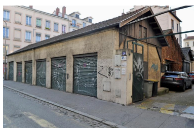
Ateliers sur la parcelle de l'immeuble Phot. Magali Delavenne IVR84_20166902138NUCA
