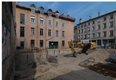
Vue d'ensemble depuis l'est, après démolition des ateliers Phot. Thierry Leroy IVR84_20196900354NUCAQ
