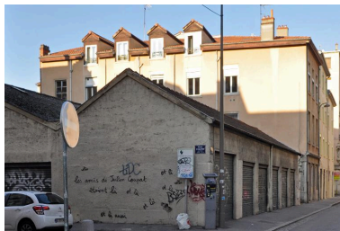
Vue d'ensemble depuis l'est, avant démolition des ateliers Phot. Magali Delavenne IVR84_20166902133NUCA
