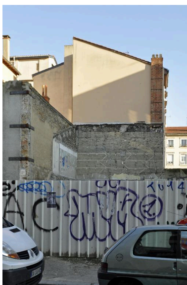
Elévation latérale sud, parties basses en pisé Phot. Magali Delavenne IVR84_20166902136NUCA
