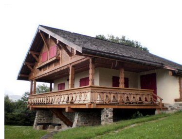
Vue d'ensemble. Etat en 2009 Phot. Mairie de Megève- Service Urbanisme IVR82_20127401919NUCA
