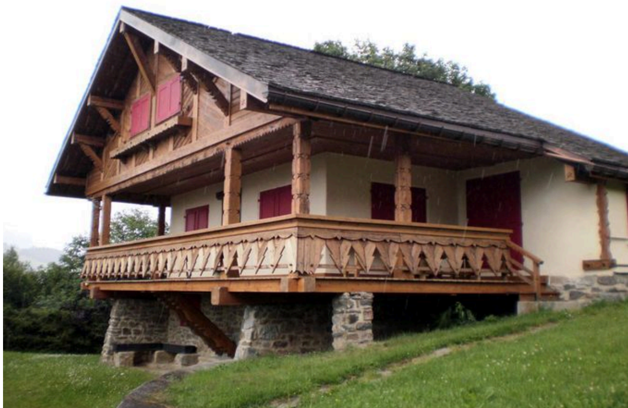
Vue d'ensemble. Etat en 2009
