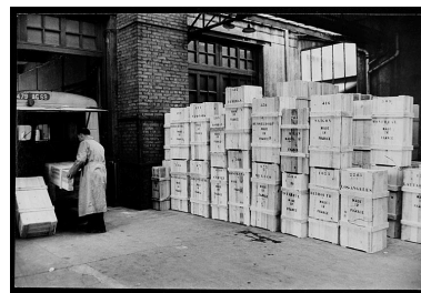
Chargement des commande de fils Repro. Jean-Marie Refflé IVR82_20016903405NUCB
