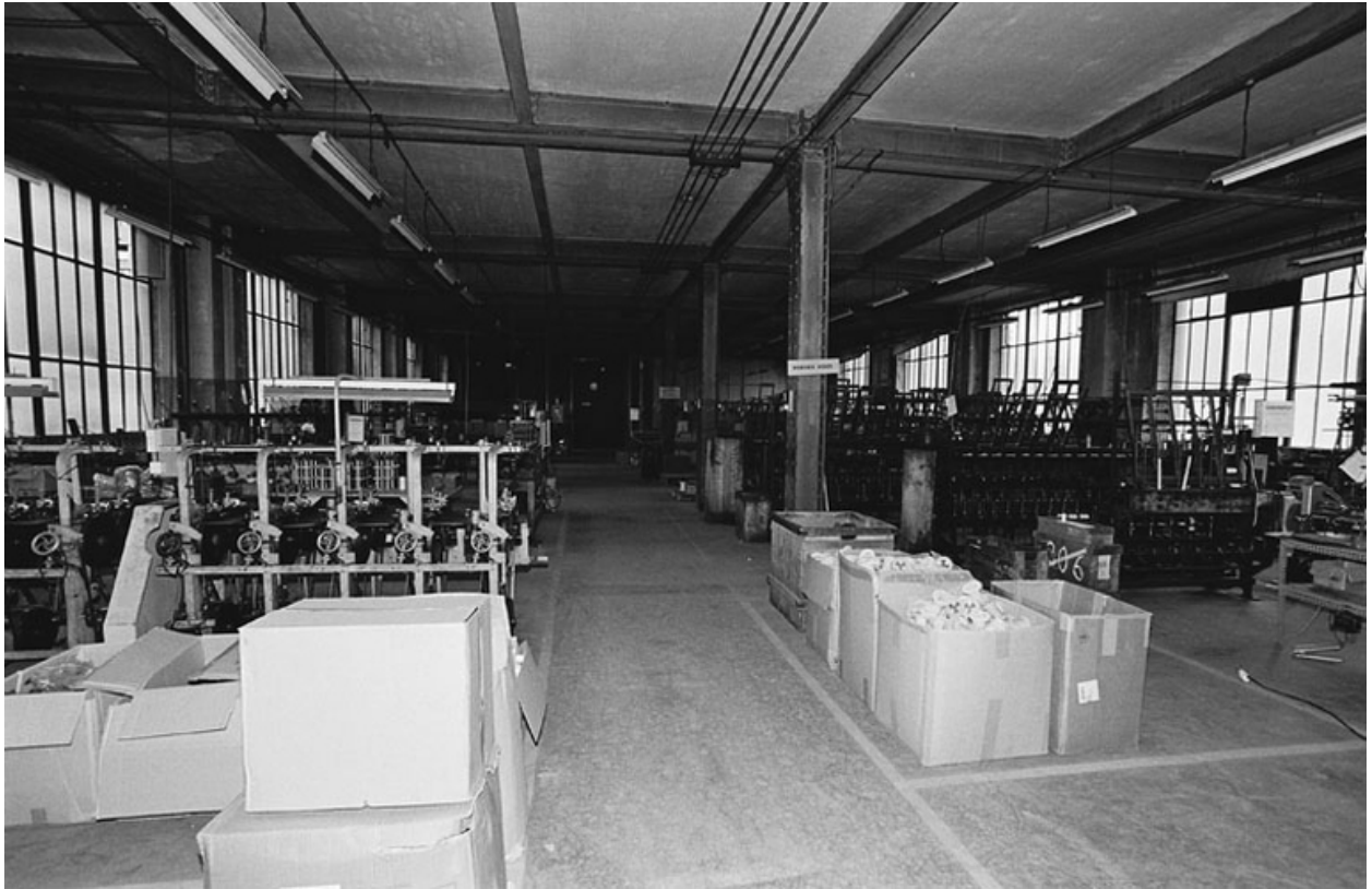
Vue d'ensemble de l'atelier ajustage et câblage localisé au 1er étage
