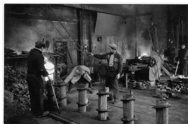
Préparation à la coulée du cuivre en fusion dans les lingotières Repro. Nadine Halitim-Dubois IVR82_20016903418NUCB
