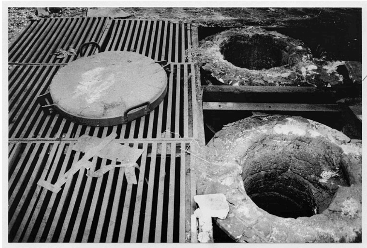
Atelier fonderie désaffecté : vue des deux fours à cuivre
