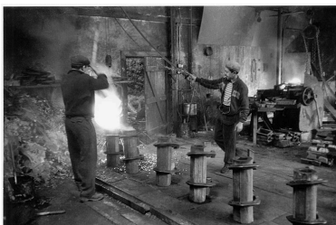
Coulée du cuivre en fusion dans la ligne des lingotières Repro. Nadine Halitim-Dubois IVR82_20016903419NUCB
