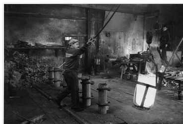
Sortie du creuset en fusion (phase 5) Repro. Nadine Halitim-Dubois IVR82_20016903417NUCB
