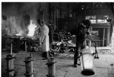
Sortie du creuset en fusion (phase 4) Repro. Nadine Halitim-Dubois IVR82_20016903416NUCB
