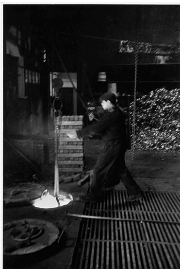
Sortie de four d'un creuset en fusion (archives privée DLMI, vers 1960) Repro. Nadine Halitim-Dubois IVR82_20016903413NUCB
