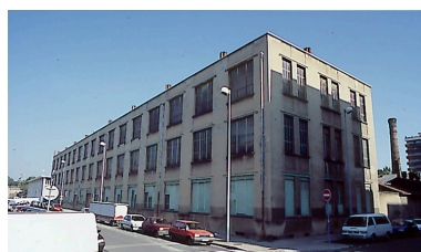
Vue générale Phot. Patrick Ageneau IVR82_19996900654ZA
