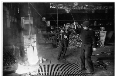
Sortie du creuset en fusion (phase 3) Repro. Nadine Halitim-Dubois IVR82_20016903415NUCB
