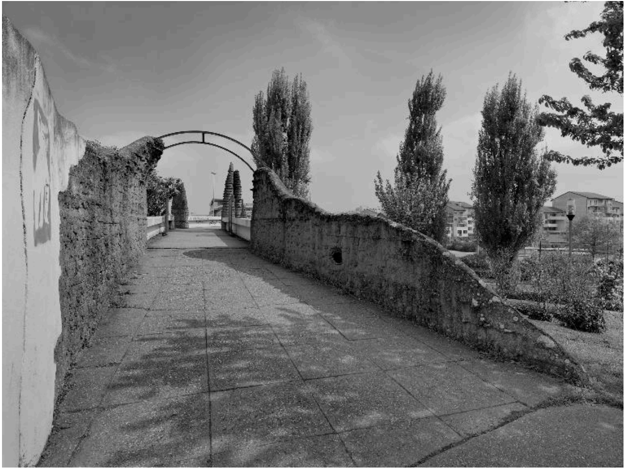
Elément sculpté habillant le mur du passage vers le lycée au débouché de la passerelle : vue intérieure
