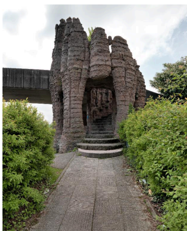
Élément monumental intégré à l'extrémité de la passerelle et à l'escalier en vis Phot. Eric Dessert IVR84_20173800030NUCA
