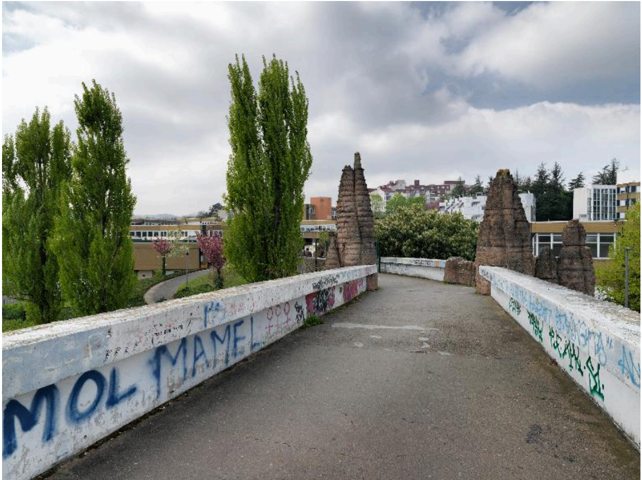
Partie haute de la passerelle
