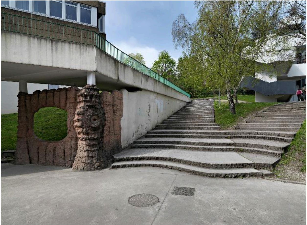
Elément monumental intégré au pilier et au mur portant la terrasse du bâtiment A et rampe.
