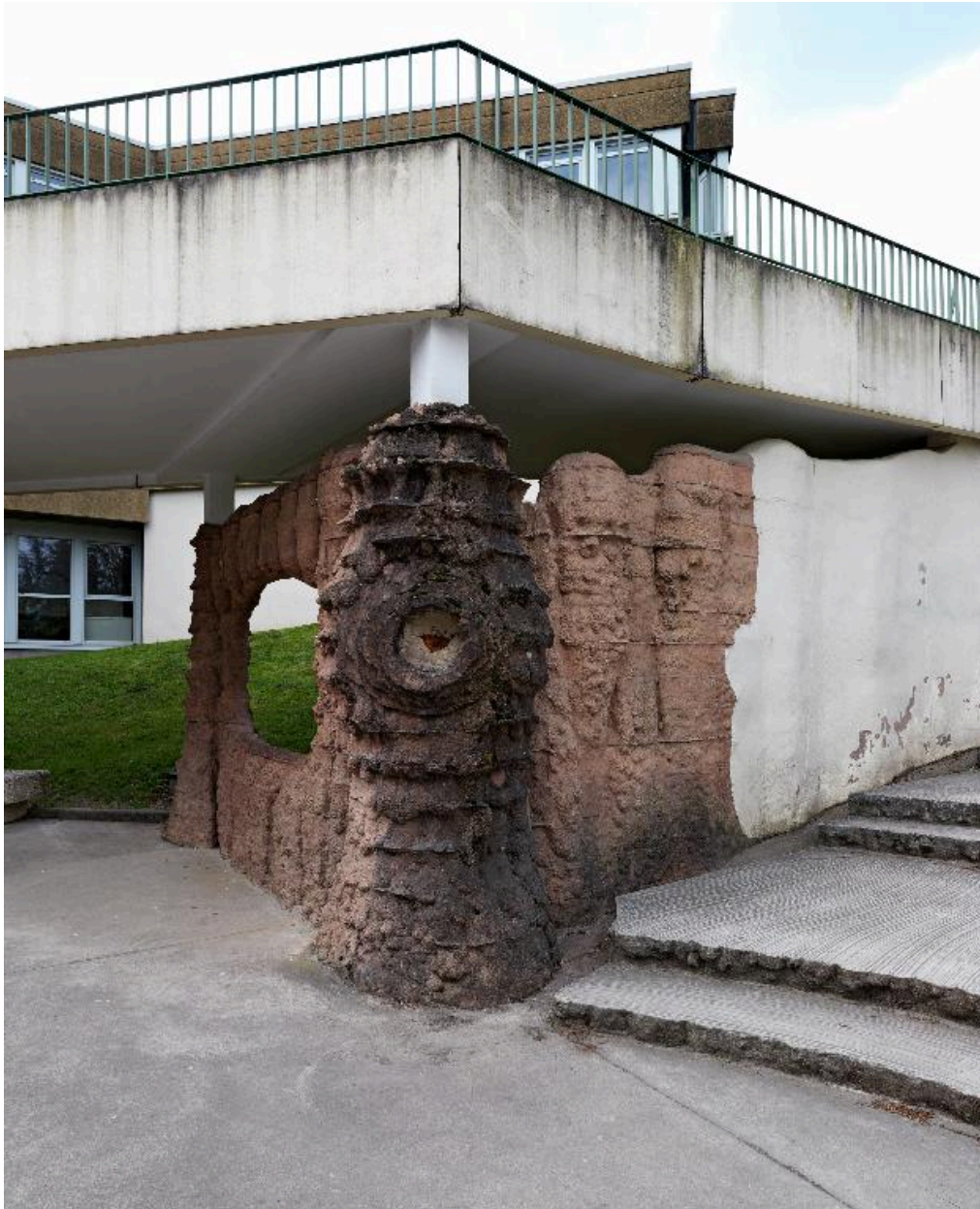
Détail de la sculpture intégrée au pilier portant la terrasse du bâtiment A
