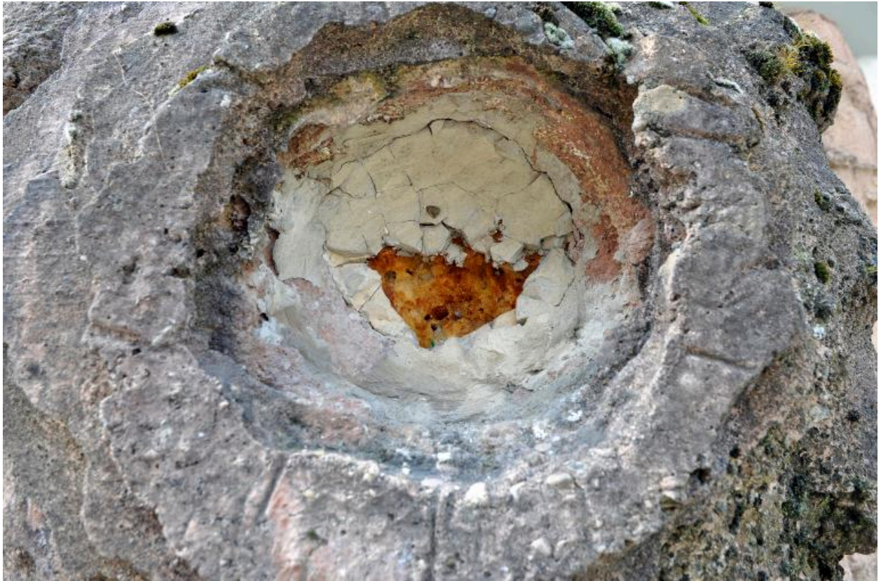
Détail d'une altération dans une partie en creux
