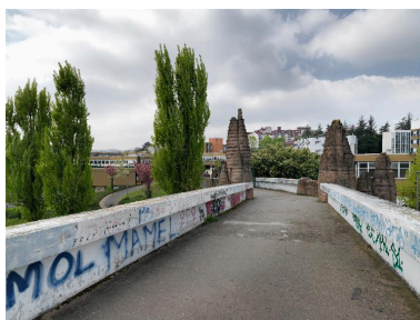
Partie haute de la passerelle Phot. Eric Dessert IVR84_20173800029NUCA
