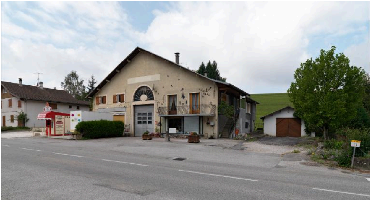
Vue d'ensemble du garage, route d'Aix-les-Bains, parcelles 1369, 1370.
