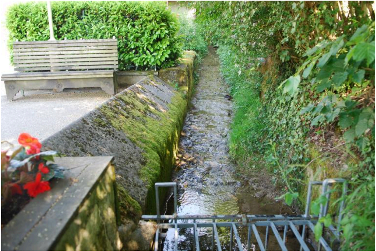
La Pallud, lavoire dans la rivière des Massettes, vue d'ensemble vers le sud
