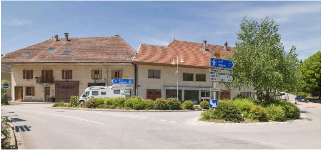
Vue d'ensemble de quelques maisons du Fay-Est (parcelles 1594, 1595 à gauche, 124 à droite)
