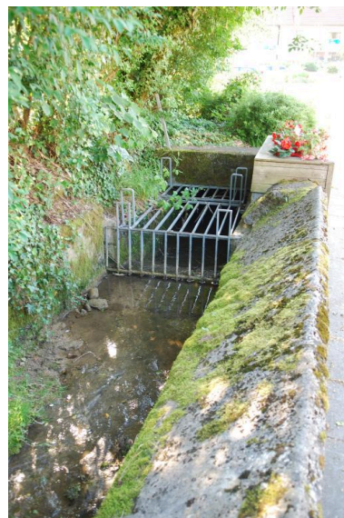
La Pallud, lavoir dans la rivière des Massettes, vue d'ensemble vers le nord Phot. Thierry Monnet IVR84_20207400129NUCA
