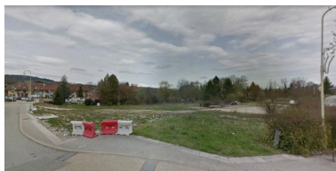
Vue d'ensemble vers l'ouest de la zone des bâtiments détruits. Phot. Thierry Monnet IVR84_20207400142NUCA
