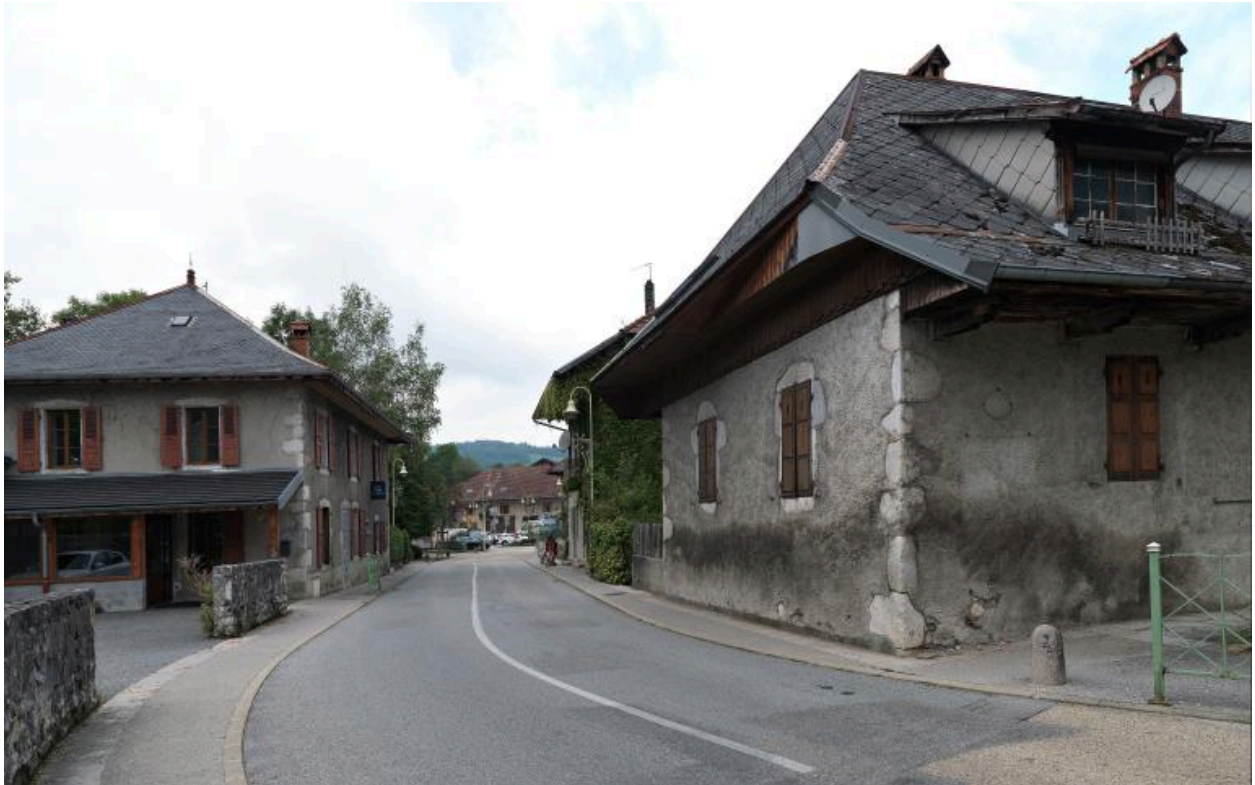
Vue d'ensemble de la route des Bauges vers l'ouest (parcelles 296 à droite, 2040 à gauche)
