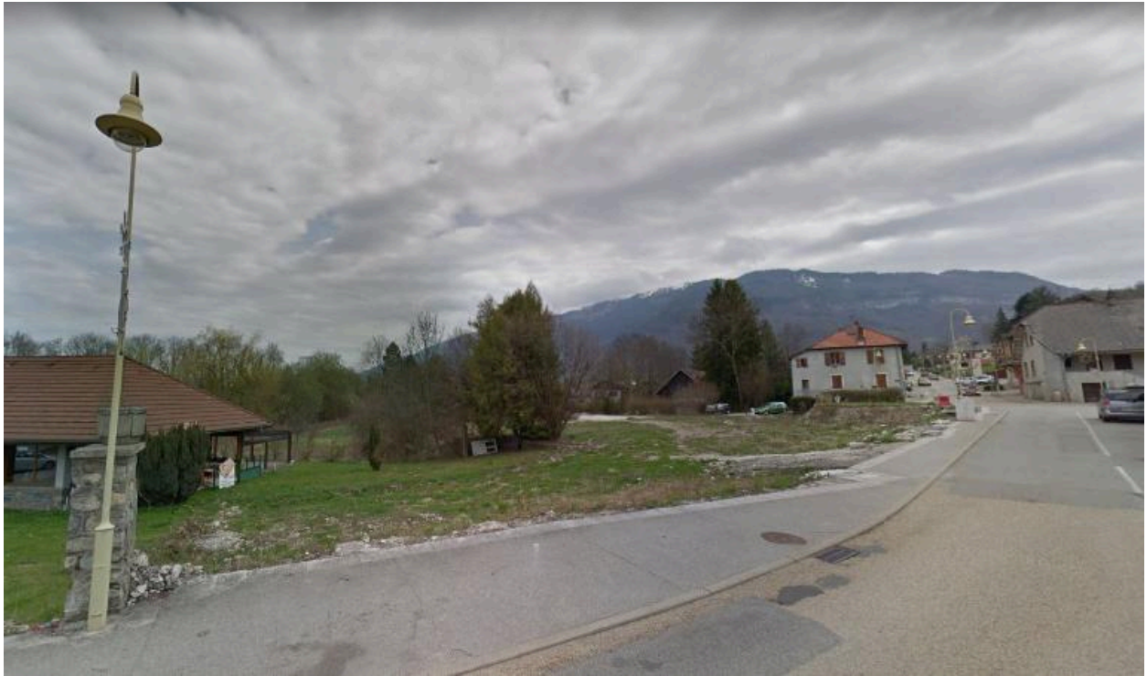
Vue d'ensemble vers l'est de la zone des bâtiments détruits.
