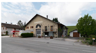
Vue d'ensemble du garage, route d'Aix-les-Bains, parcelles 1369, 1370.
