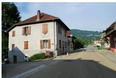
La Pallud, vue d'ensemble de la route des Bauges vers l'est. Parcelle n° 2048 à gauche. Phot. Thierry Monnet IVR84_20207400128NUCA
