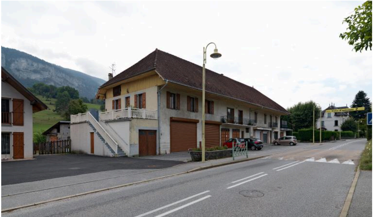
Ancien hôtel-restaurant "A la truite vivante", parcelle 2154, route d'Aix-les-Bains.
