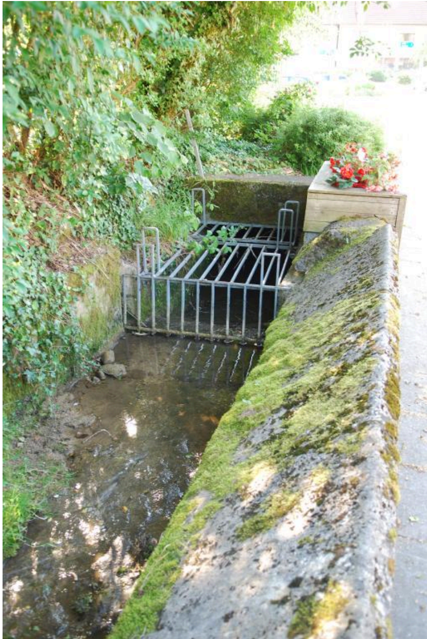
La Pallud, lavoir dans la rivière des Massettes, vue d'ensemble vers le nord
