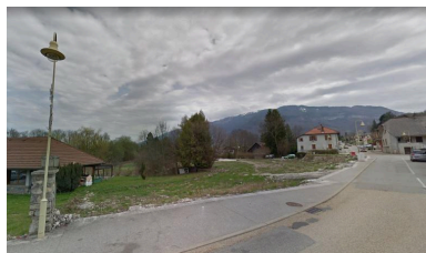
Vue d'ensemble vers l'est de la zone des bâtiments détruits. Phot. Thierry Monnet IVR84_20207400141NUCA
