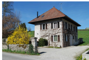
La Fay-est, 2015 B3 1952, maison, vue d'ensemble de trois-quarts avant droite Phot. Thierry Monnet IVR84_20207400133NUCA
