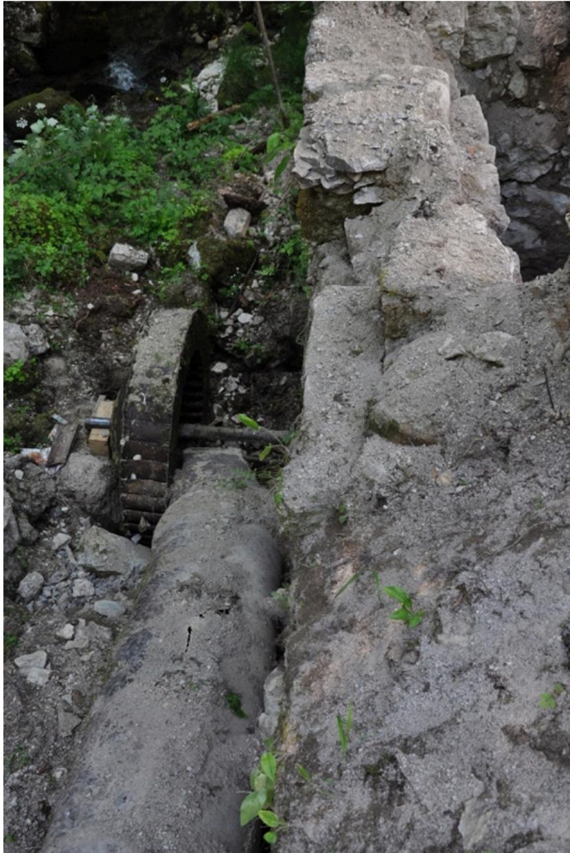
Détail de la conduite forcée et de la roue verticale métallique
