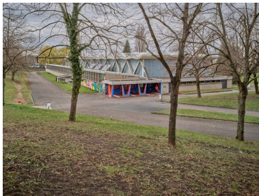
Le gymnase vu depuis l'intérieur du lycée Phot. Christian Parisey IVR84_20250300307NUC4A
