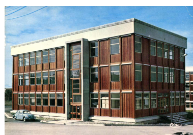
Un bâtiment avec son bardage de bois originel (v. 1970?) (AC Cusset)
