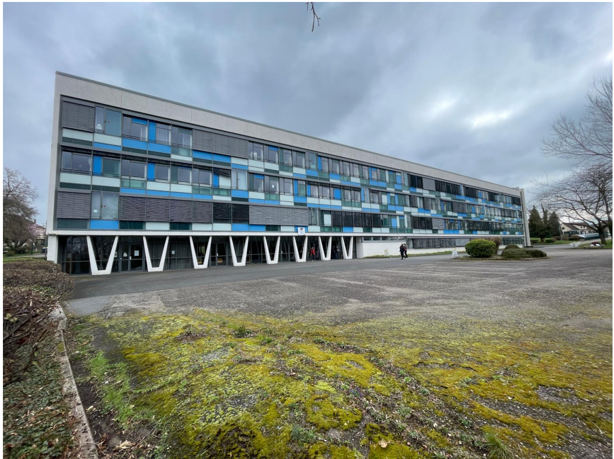
Bâtiment C, vue d'ensemble
