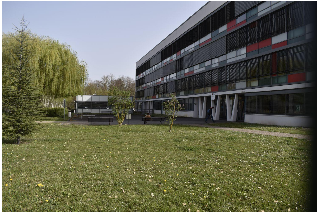
Bâtiment A actuel, tel que restructuré par l'extérieur. Les "V" des poteaux du préau n'ont en revanche pas disparu.
