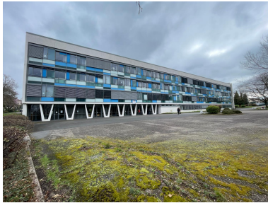
Bâtiment C, vue d'ensemble Phot. Catherine Guégan IVR84_20250300365NUCA
