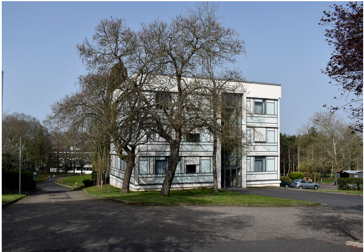
Un bâtiment après restructuration et "rhabillage" des façades
