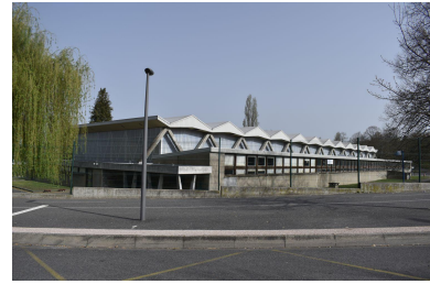
Le gymnase, vue depuis l'espace public, unique bâtiment qui semble n'avoir pas été restructuré. Phot. Bénédicte Renaud-Morand IVR84_20230300083NUCA
