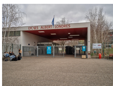
Entrée du lycée Phot. Christian Parisey IVR84_20250300311NUC4A
