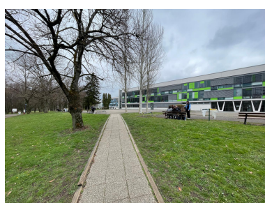
Bâtiment B, vue d'ensemble
