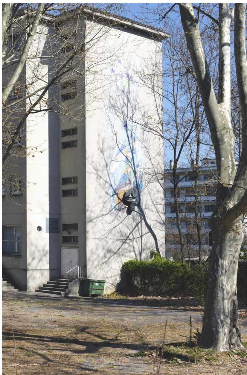
Composition monumentale du bâtiment C, état en 2021.
