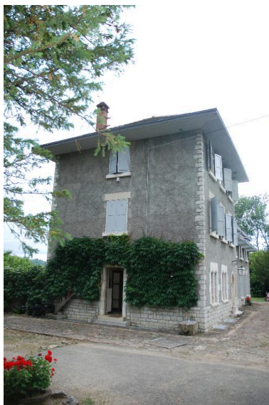
Vue de trois-quarts. Phot. Thierry Monnet IVR84_20177301254NUCA
