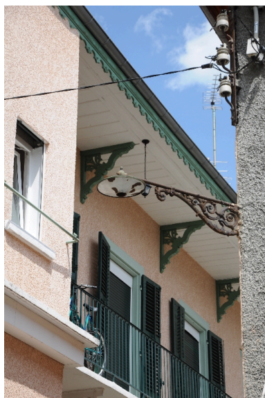
Détail de l'avant-toit Phot. François Fouger IVR82_20127300294NUCA
