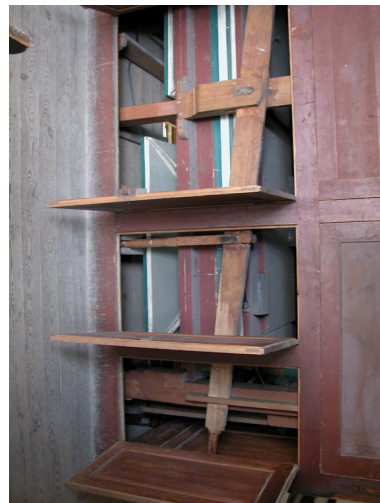
Vue du mécanisme. Phot. Thierry Monnet IVR82_20104200261NUCA
