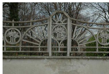
Mur de clôture en béton armé, à motifs de paniers fleuris (détruit après inventaire), 20 montée de Rigaud (BO 48) Phot. Simone Hartmann-Nussbaum IVR82_20134202065NUCA
