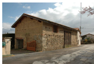
Dépendance agricole (BC 325), hameau de Curtieux Phot. Simone Hartmann-Nussbaum IVR82_20144200464NUCA
