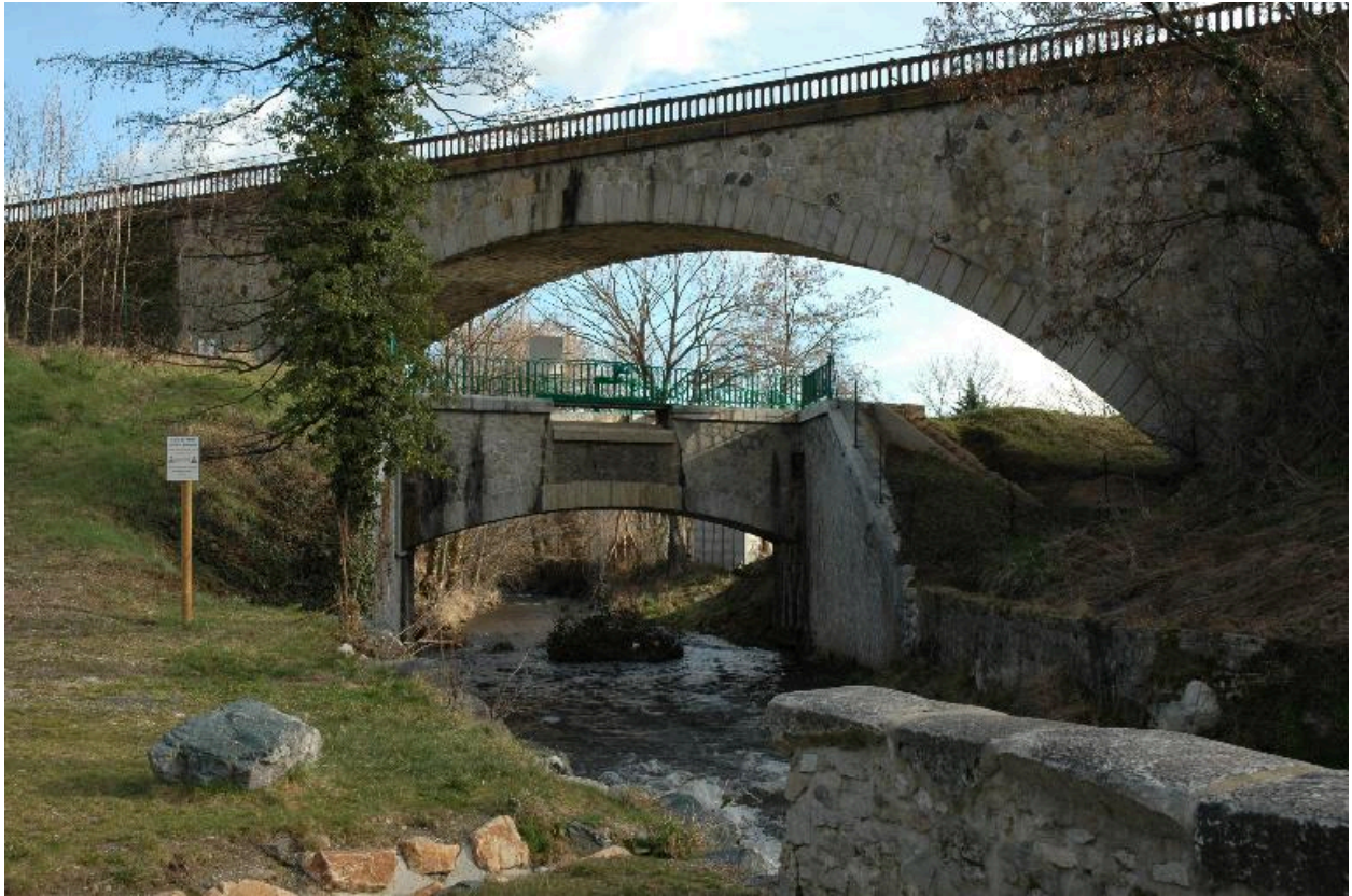
Vue partielle du canal du Forez
