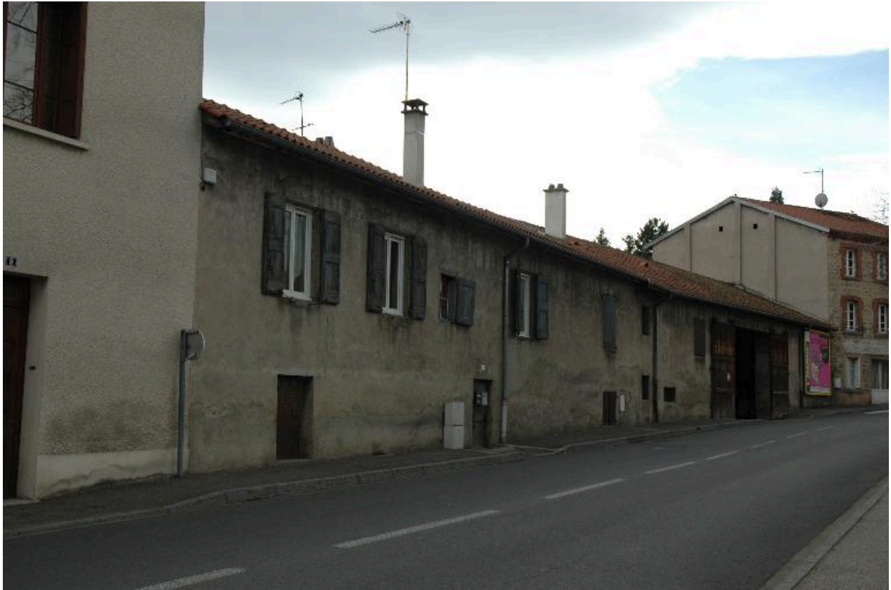
Ferme (BO 10), 11 rue du Parc
