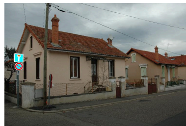
Habitat répétitif le long de la rue de Bichirand, n° 8-10 (BO 79, 80) Phot. Simone Hartmann-Nussbaum IVR82_20144200442NUCA
