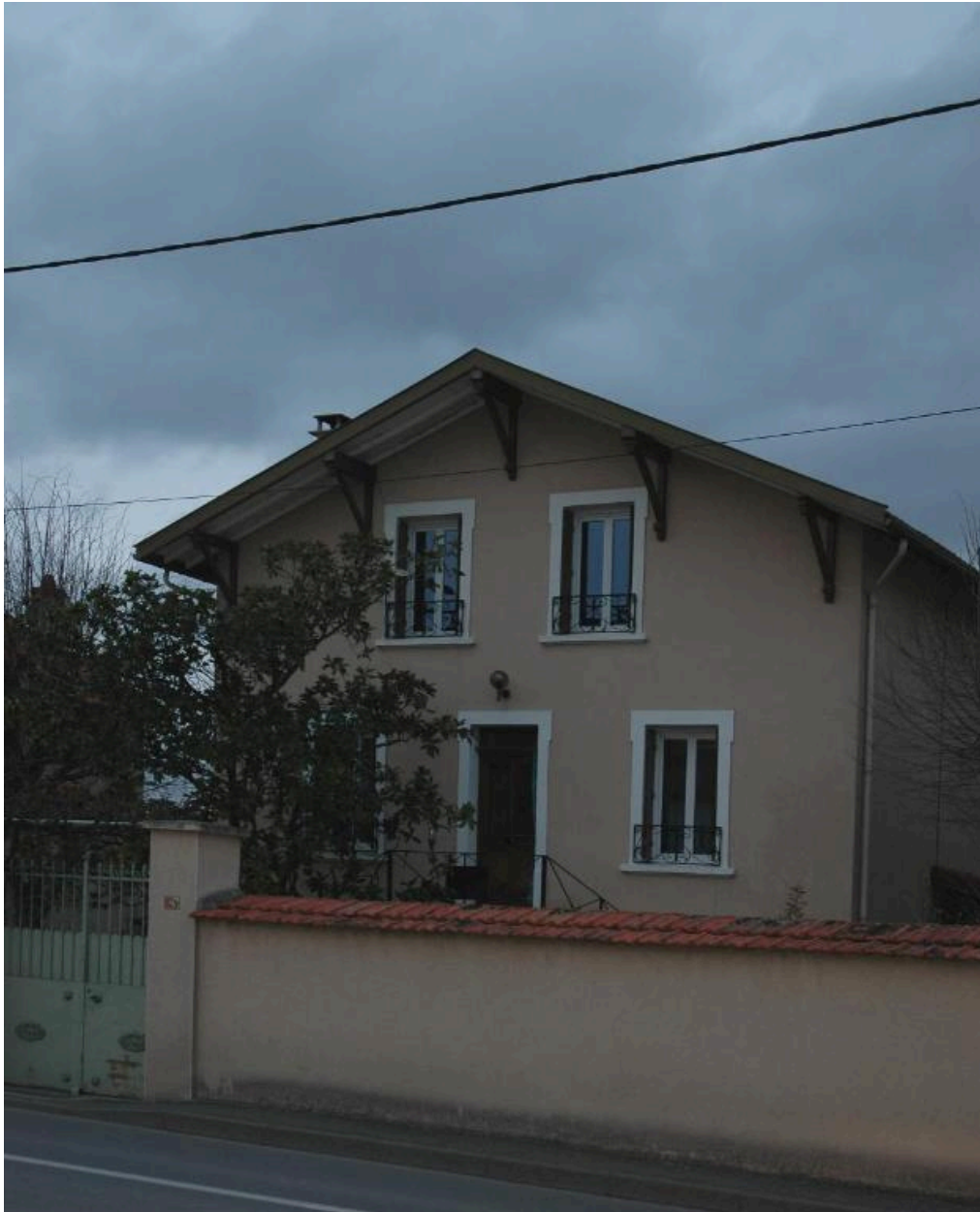
Maison, dite Villa Bon accueil, 9 rue de Feurs (BH 60)
