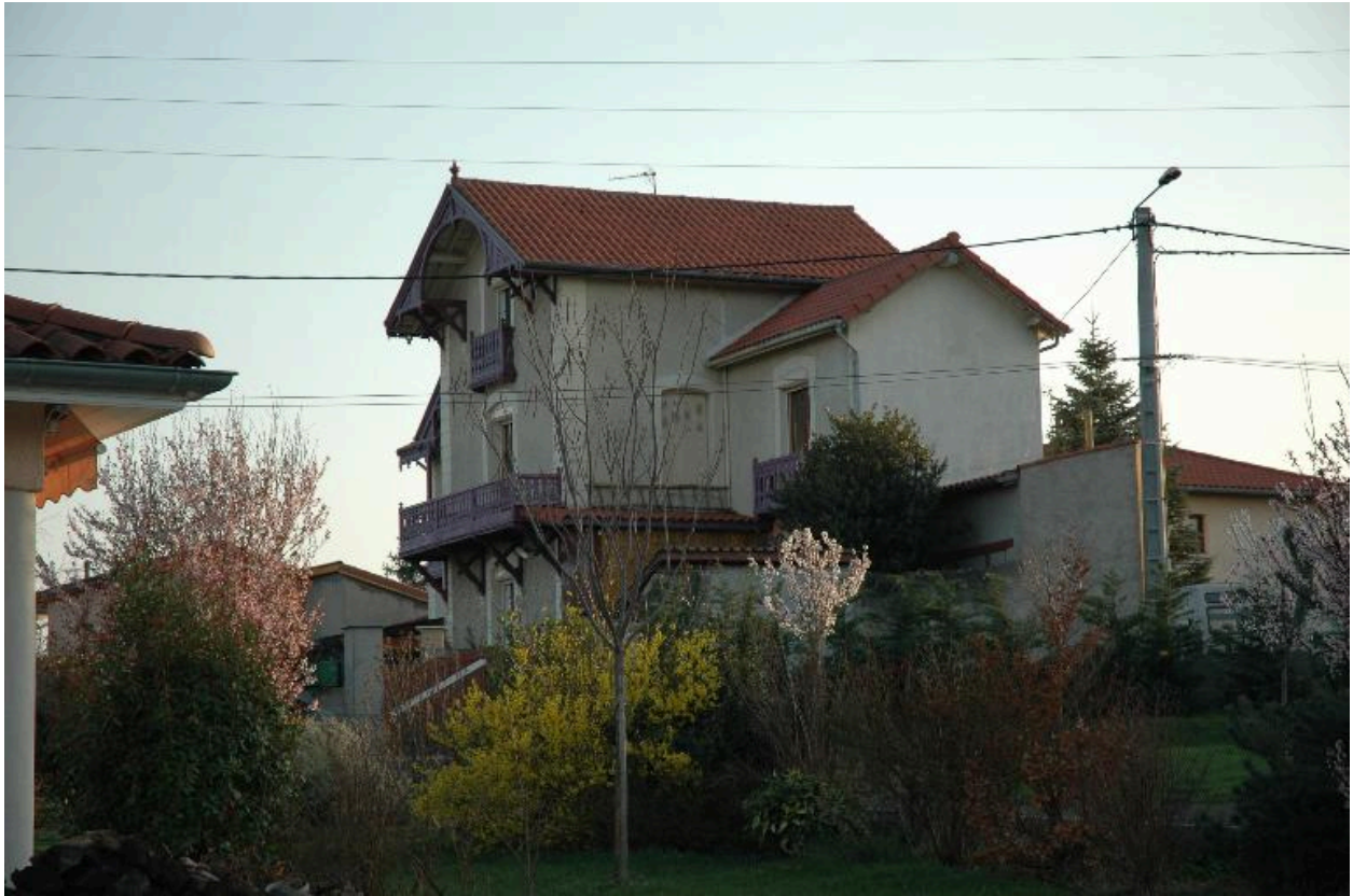
Corps central évoquant timidement le pittoresque d'un bévédère, 8 allée du Bouchet (AV 218)
