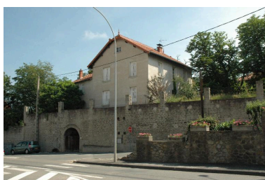
Demeure avec jardin en terrasse, 25 avenue de la Libération (BN 17) Phot. Simone Hartmann-Nussbaum IVR82_20144200447NUCA
