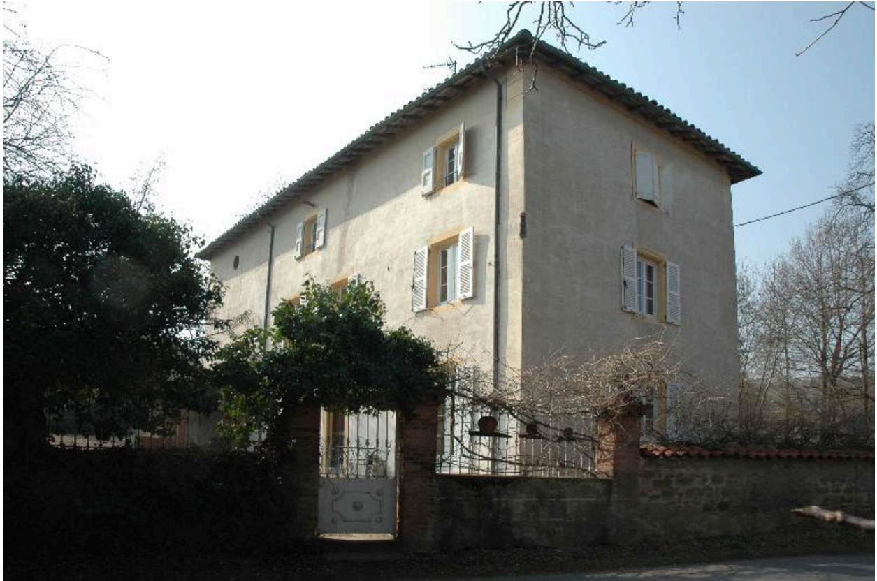
Ferme (AV 672), route départementale n° 101
