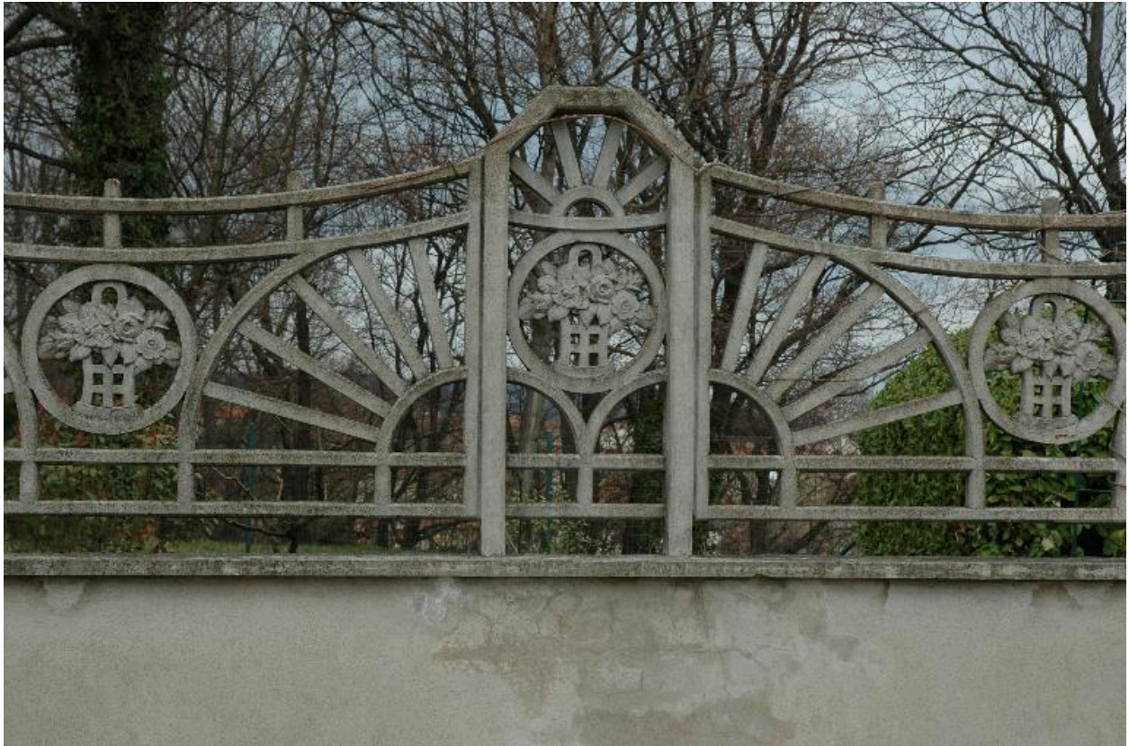
Mur de clôture en béton armé, à motifs de paniers fleuris (détruit après inventaire), 20 montée de Rigaud (BO 48)
