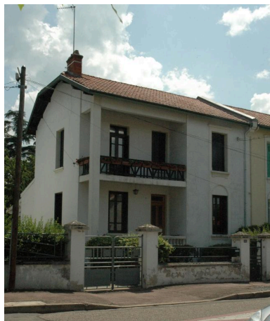
Maison avec balcon en retrait, 42 rue d'Alsace-Lorraine (BN 67) Phot. Simone Hartmann-Nussbaum IVR82_20144200440NUCA
