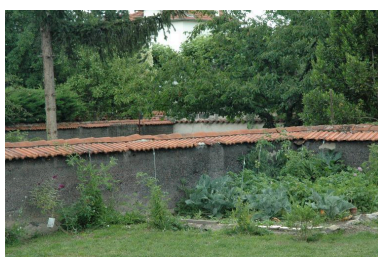
Murs de clôture en mâchefer (BO 79), 8 rue de Bichirand Phot. Simone Hartmann-Nussbaum IVR82_20144200454NUCA
