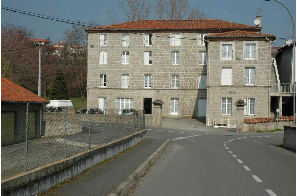
Ancien moulin à farine, dit moulin Maillon, chemin des Meuniers (AT 828)
