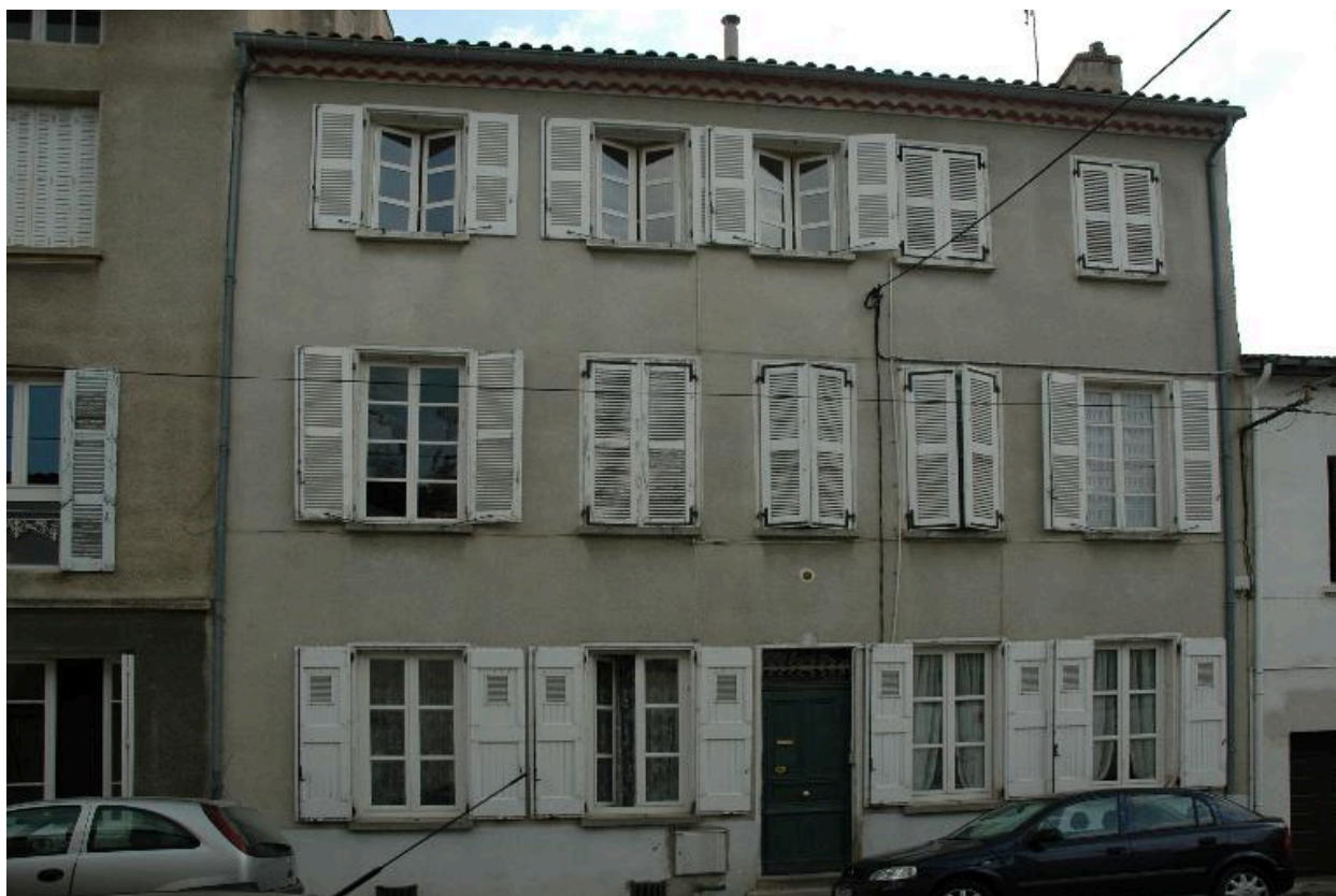
Immeuble, 4 rue des Moulins (AW 43)
