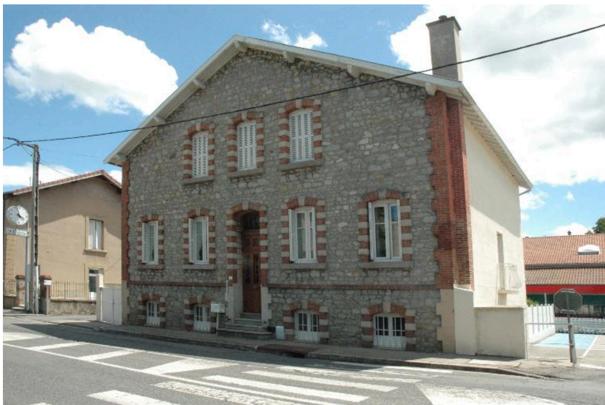
Utilisation de la pierre et de la brique en décor sur l'élévation principale, 42 rue de la République (BL 265)
