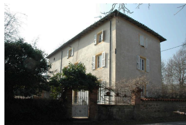
Ferme (AV 672), route départementale n° 101 Phot. Simone Hartmann-Nussbaum IVR82_20144200461NUCA
