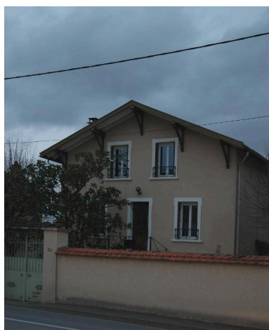
Maison, dite Villa Bon accueil, 9 rue de Feurs (BH 60) Phot. Simone Hartmann-Nussbaum IVR82_20144200432NUCA
