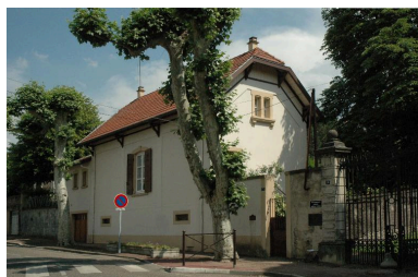
Demeure, 52 avenue d'Alsace-Lorraine (BN 71) Phot. Simone Hartmann-Nussbaum IVR82_20144200443NUCA
