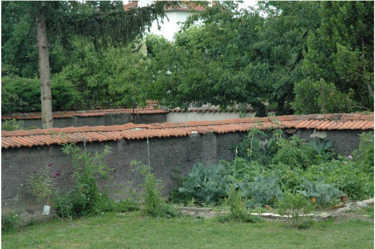
Murs de clôture en mâchefer (BO 79), 8 rue de Bichirand
