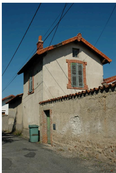
Ancienne loge (BD 241), chemin des Vignes Phot. Simone Hartmann-Nussbaum IVR82_20144200456NUCA
