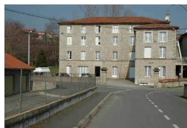
Ancien moulin à farine, dit moulin Maillon, chemin des Meuniers (AT 828) Phot. Simone Hartmann-Nussbaum IVR82_20144200413NUCA
