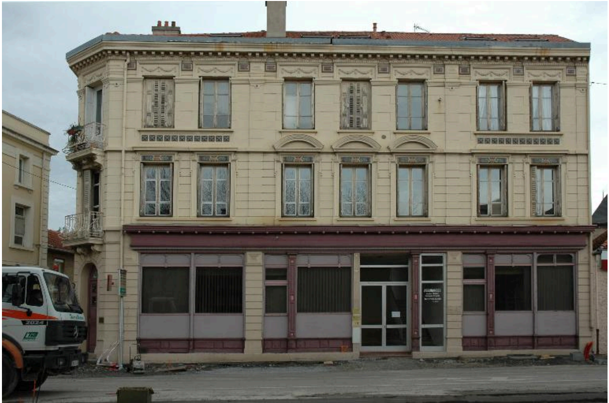
Immeuble, avenue de la Libération (BL 193)
