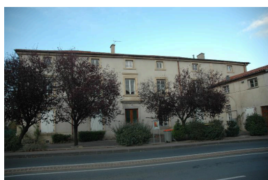
Le domaine de Montchenu édifié en 1830 (actuellement maison Saint-Joseph). Phot. Simone Hartmann-Nussbaum IVR82_20144200452NUCA
