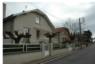
Habitat pavillonnaire situé le long de la rue du 8 mai, n° 11-15 (BO 36, 37, 38) Phot. Simone Hartmann-Nussbaum IVR82_20144200425NUCA
