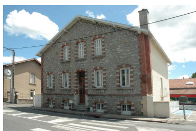
Utilisation de la pierre et de la brique en décor sur l'élévation principale, 42 rue de la République (BL 265) Phot. Simone Hartmann-Nussbaum IVR82_20144200446NUCA
