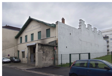
Vue nord-est détail pignon Phot. Géraldine Millo IVR82_20076900756NUCA
