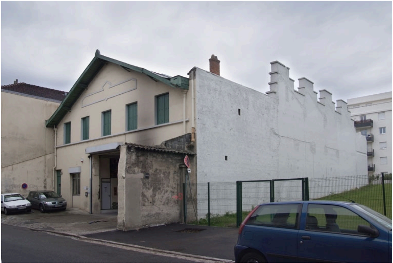
Vue nord-est détail pignon
