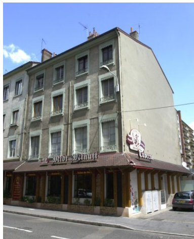
Vue de 3/4 depuis le sud-est Phot. François Blanchetière IVR82_20016901976NUCA
