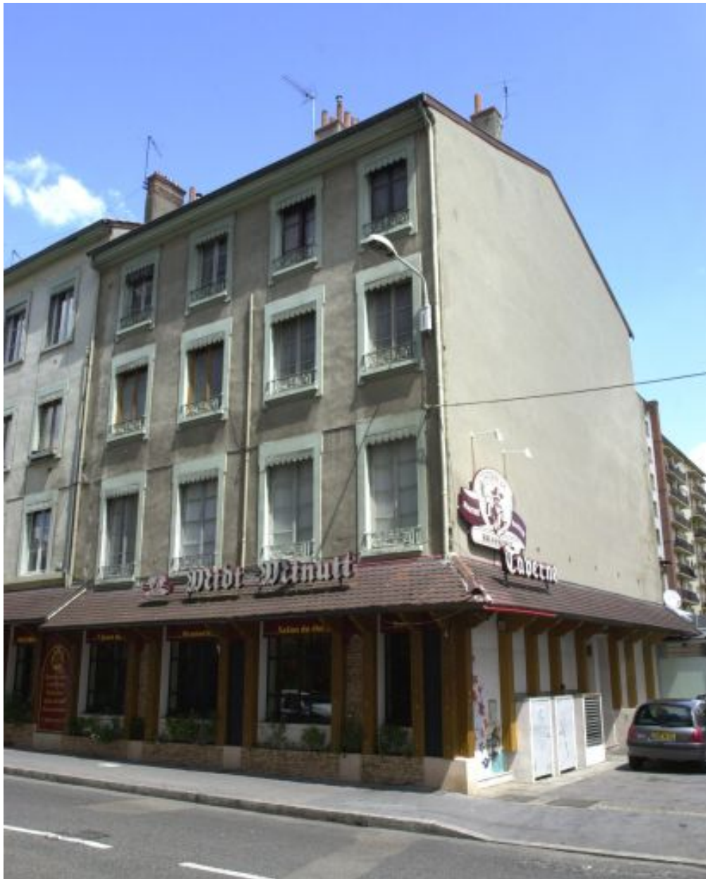
Vue de 3/4 depuis le sud-est
