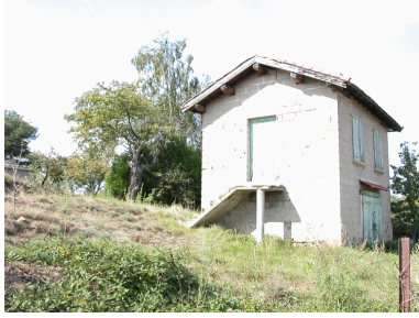
Vue générale. Phot. Thierry Monnet IVR82_20124201687NUCA
