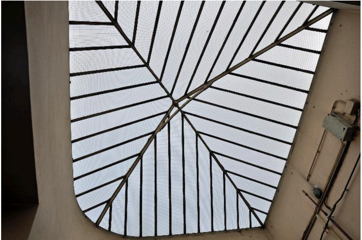
Vue de la verrière couvrant la tour d'escalier
