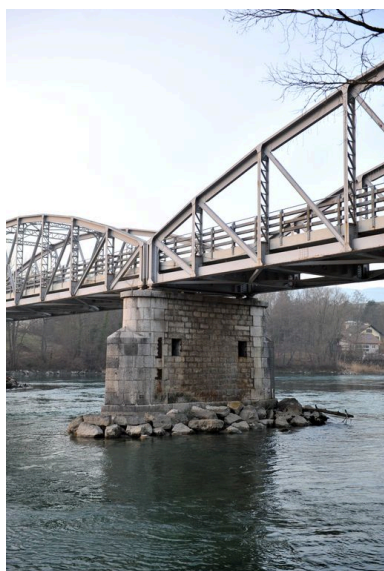
Vue partielle, pile gauche, face aval (depuis la rive gauche) Phot. G. Gellert IVR82_20100100437NUCA
