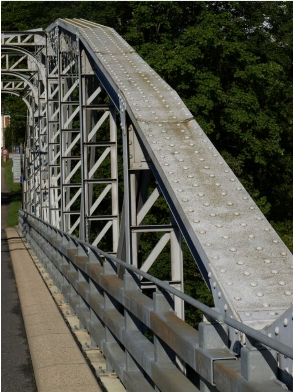
Vue partielle, de dessus, arche droite de la face amont (depuis la rive gauche)
