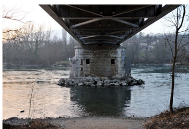
Vue de dessous, tablier et pile (depuis la rive gauche) Phot. G. Gellert IVR82_20100100441NUCA
