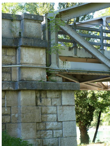
Culée gauche, vue de détail : jonction avec l'arche (depuis la rive gauche) Phot. B. Decrock IVR82_20100100440NUCA
