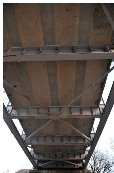
Travée gauche, de dessous, vue de détail : tablier et structures métalliques Phot. G. Gellert IVR82_20100100442NUCA
