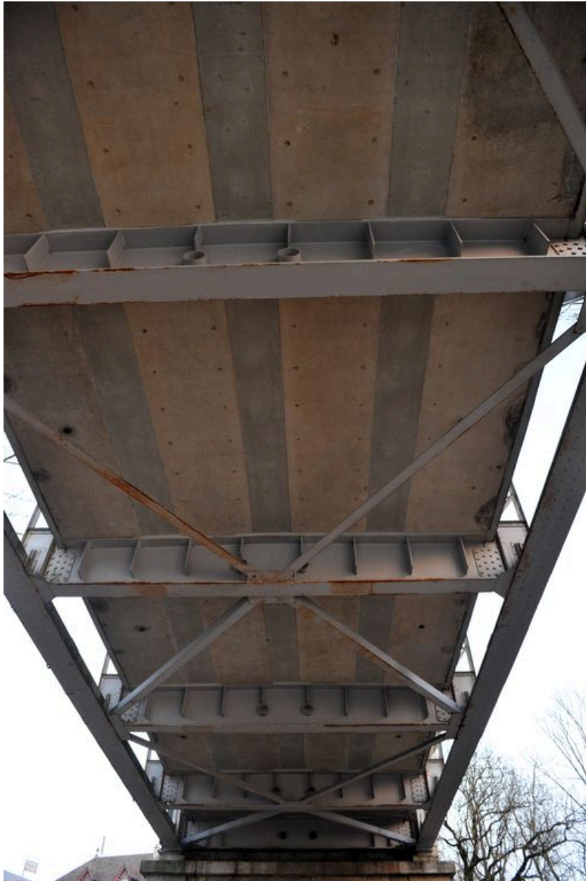
Travée gauche, de dessous, vue de détail : tablier et structures métalliques
