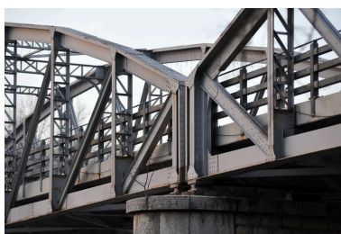
Pile gauche, face aval, vue de détail : jonction avec les arches (depuis la rive gauche) Phot. G. Gellert IVR82_20100100438NUCA
