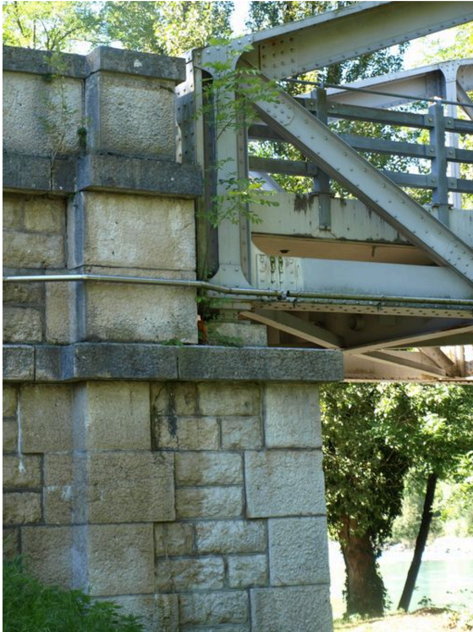
Culée gauche, vue de détail : jonction avec l'arche (depuis la rive gauche)
