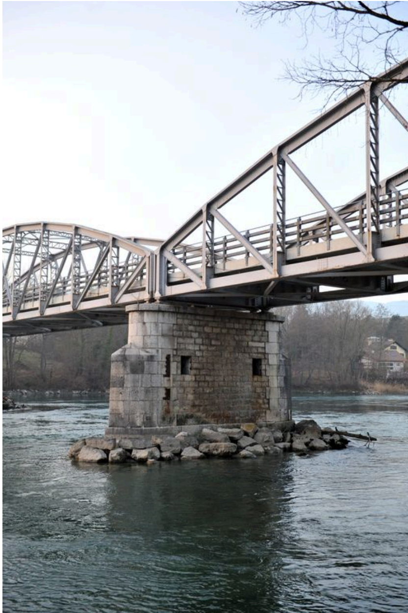
Vue partielle, pile gauche, face aval (depuis la rive gauche)
