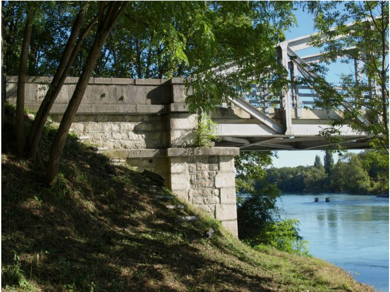
Vue partielle, culée droite, face aval (depuis la rive droite)
