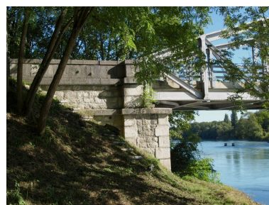
Vue partielle, culée droite, face aval (depuis la rive droite) Phot. B. Decrock IVR82_20100100439NUCA
