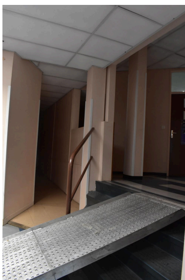
Cage d'escalier situé côté est du bâtiment A 29 (bâtiment principal du lycée) : IPN de la structure métallique générale bien visible et tubes métalliques des rampes. Phot. Christian Parisey IVR84_20226301690NUCA
