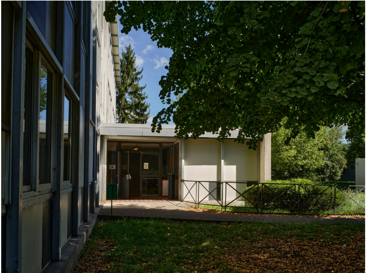
Bâtiment bas d'entrée dans le bâtiment principal du lycée, depuis la cour de récréation.
