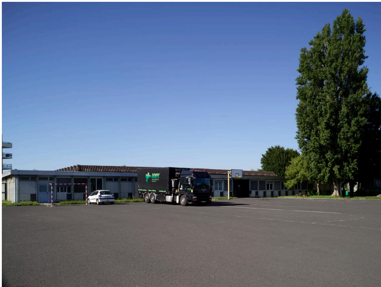
Vue depuis la cour de récréation sur le bâtiment des ateliers du lycée.
