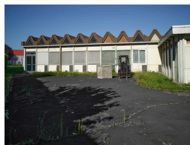
Bâtiment H3 des ateliers, vu depuis la pointe sud de la parcelle. Sheds en coques acier. Phot. Christian Parisey IVR84_20226301682NUCA
