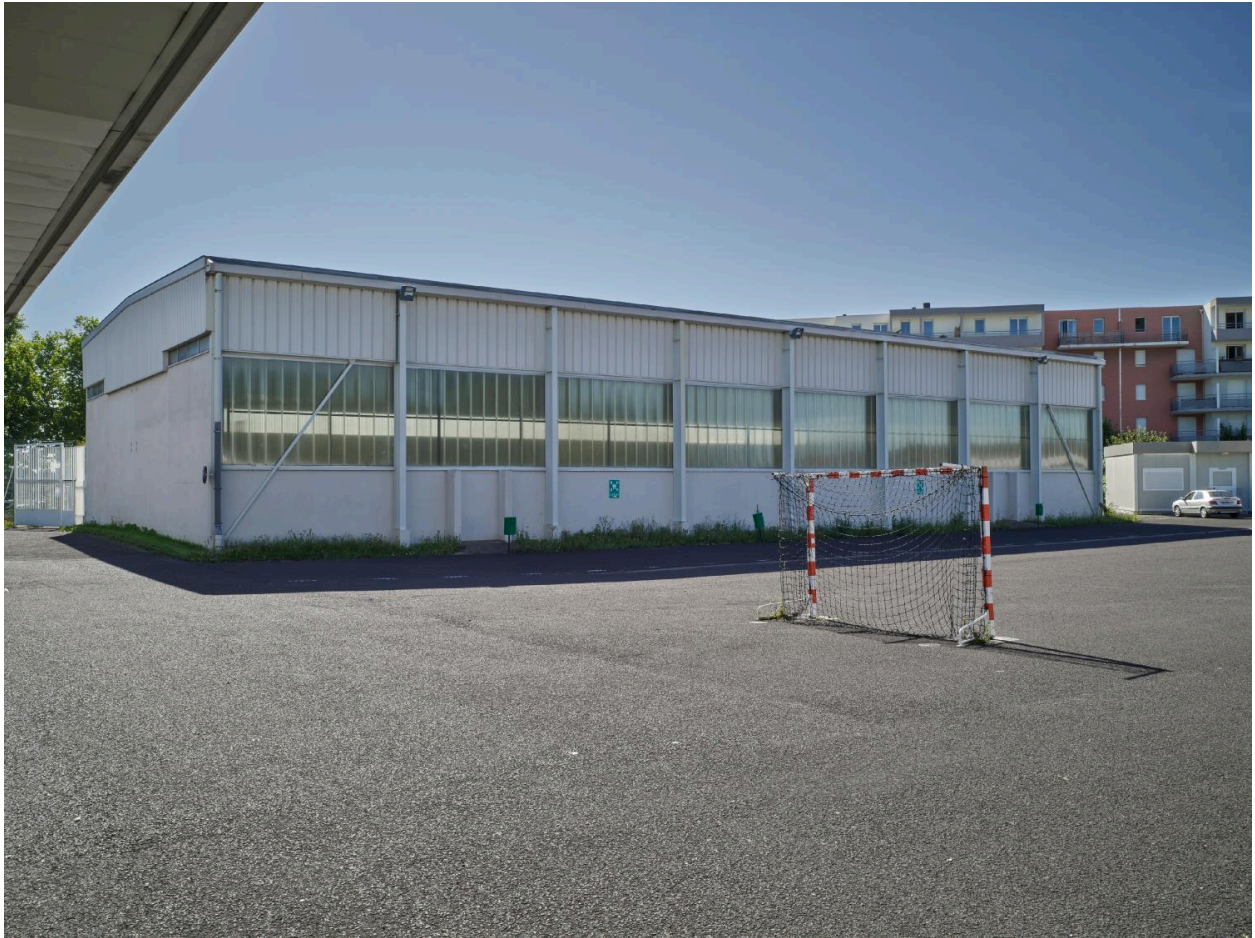
Gymnase municipal partagé avec le lycée et collège. Construit entre 1972 et 1974.
