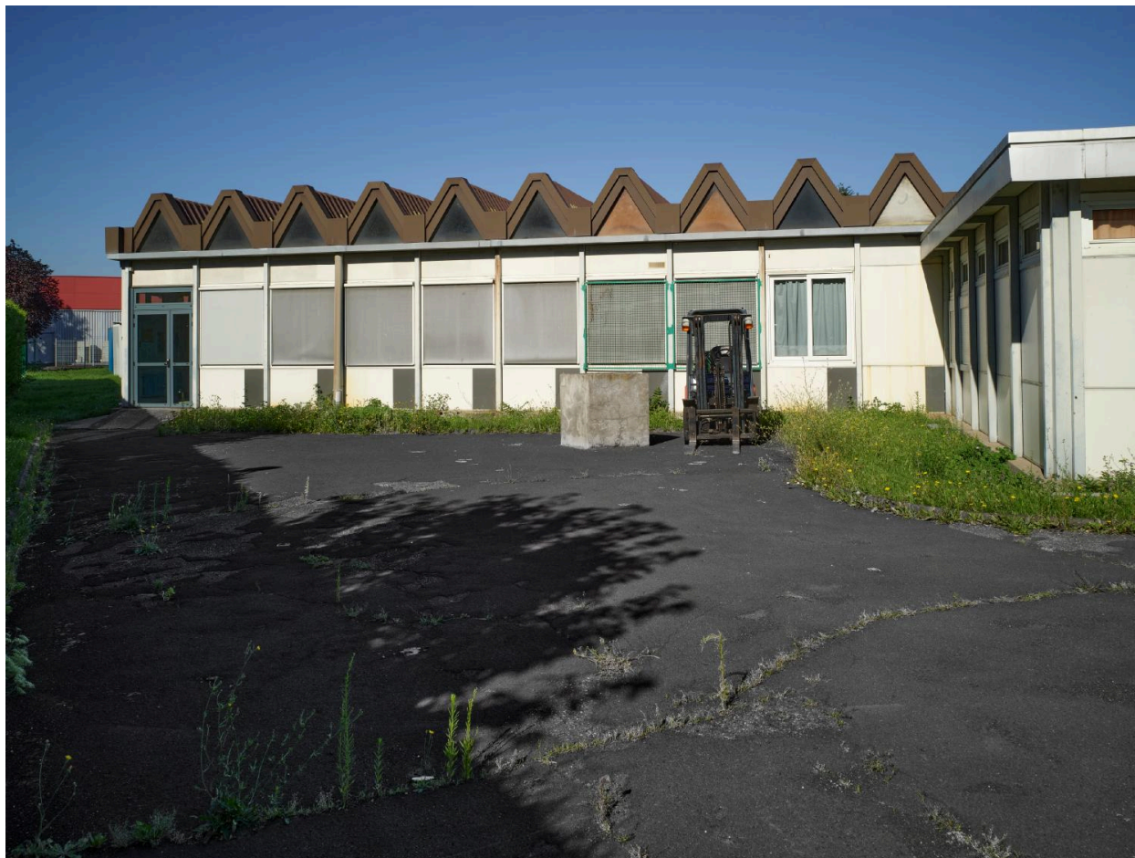
Bâtiment H3 des ateliers, vu depuis la pointe sud de la parcelle. Sheds en coques acier.
