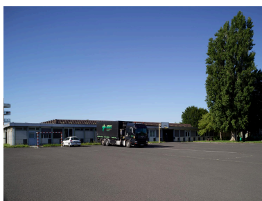
Vue depuis la cour de récréation sur le bâtiment des ateliers du lycée. Phot. Christian Parisey IVR84_20226301683NUCA
