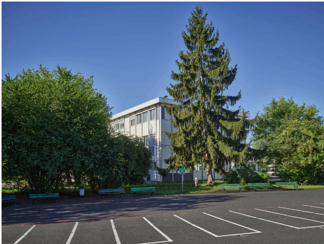
Vue depuis la cour de récréation du collège (CES 900 à l'origine) sur le bâtiment des salles de cours du lycée (CET 540).
