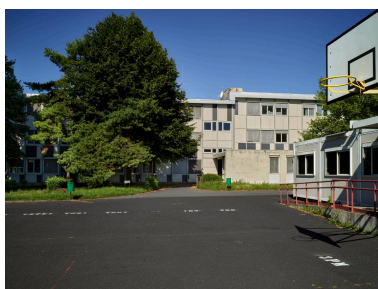
Bâtiment principal du lycée (avec un décrochement dans la hauteur qu'on ne s'explique pas). Le bâtiment bas est celui de l'entrée par le côté cour et de la salle de dessin d'art et de collections (d'après le plan initial de 1971). Phot. Christian Parisey IVR84_20226301689NUCA
