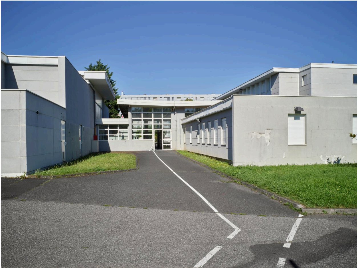
A gauche : bâtiment du collège comprenant un petit gymnase et la cantine (partagée avec le lycée). A droite, bâtiments du collège, et au centre, corps de bâtiment ajouté entre 1996 et 1999.
