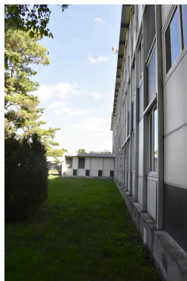
Façade du bâtiment A29 du CET, avec, au nord et accolé, un bâtiment bas avec l'entrée, la salle des professeurs et la bibliothèque (destinations des pièces notées sur le plan initial de 1971). Phot. Bénédicte Renaud-Morand IVR84_20226301752NUCA
