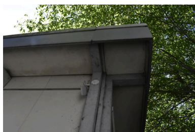
Détail de la structure métallique du bâtiment des ateliers. Phot. Bénédicte Renaud-Morand IVR84_20226301751NUCA
