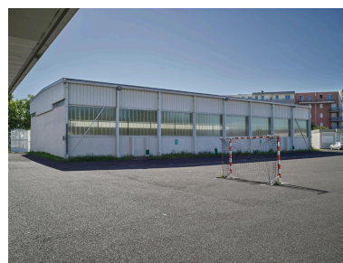
Gymnase municipal partagé avec le lycée et collège. Construit entre 1972 et 1974. Phot. Christian Parisey IVR84_20226301686NUCA
