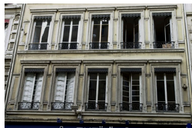
Façade, 2e et 3e niveaux Phot. Bernard Ducouret IVR82_20046900923NUCA
