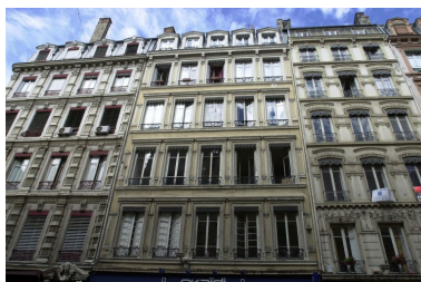
Façade, vue générale par-dessous Phot. Bernard Ducouret IVR82_20046900922NUCA
