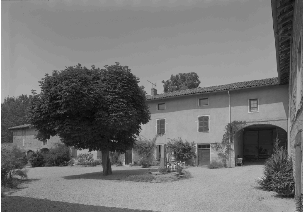
Vue d'ensemble sur cour, depuis le sud : corps de logis et porche nord.
