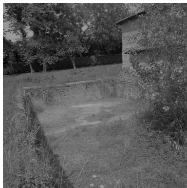
Bassin d'arrosage, à l'extérieur de la cour.
