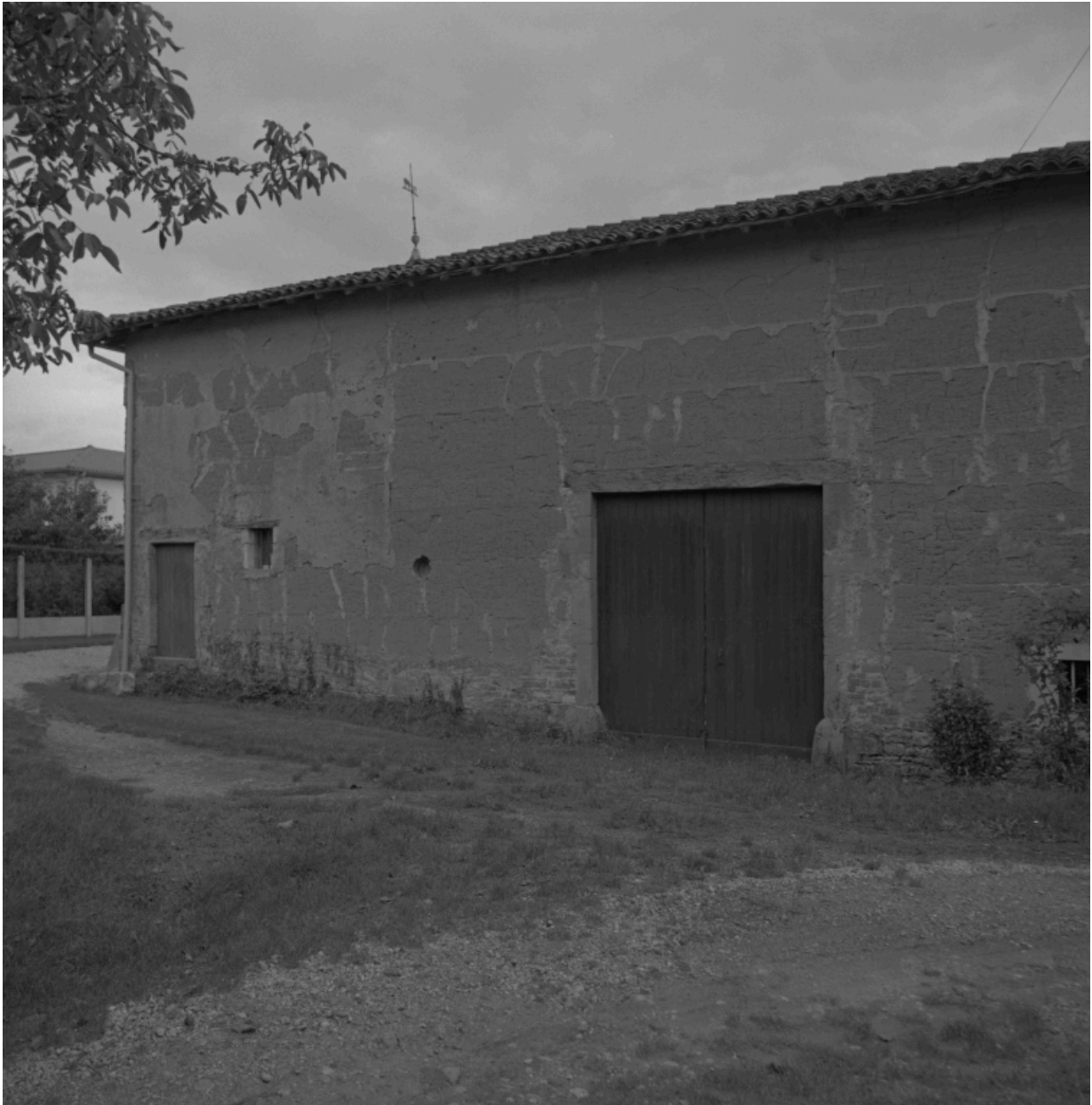
Elévation postérieure partielle côté nord : porche et dépendance.
