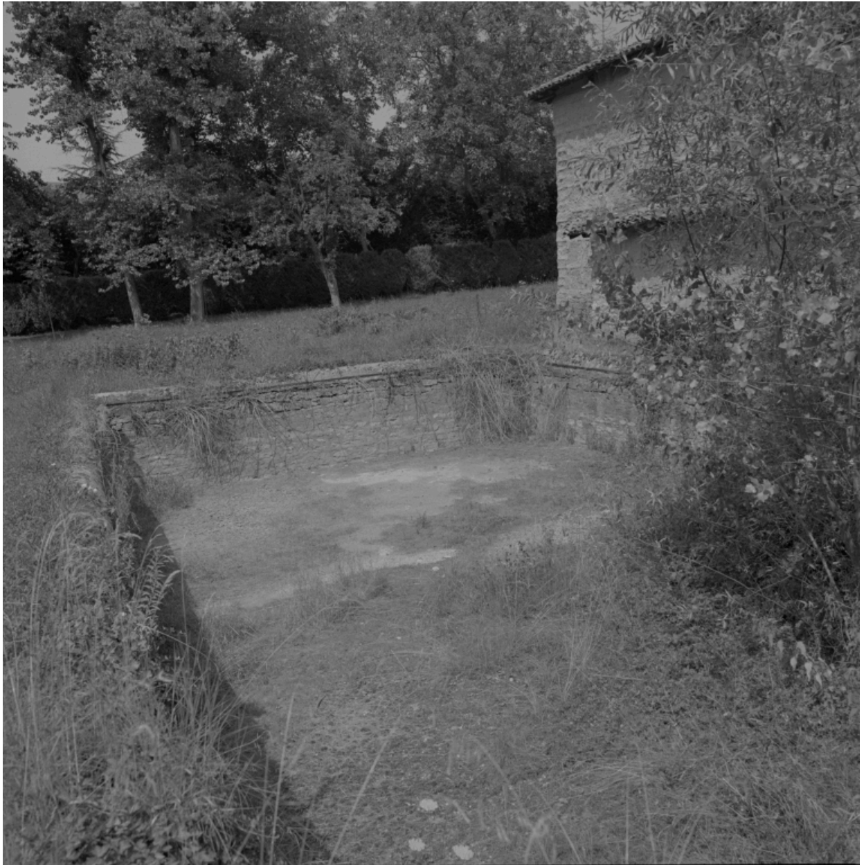
Bassin d'arrosage, à l'extérieur de la cour.
